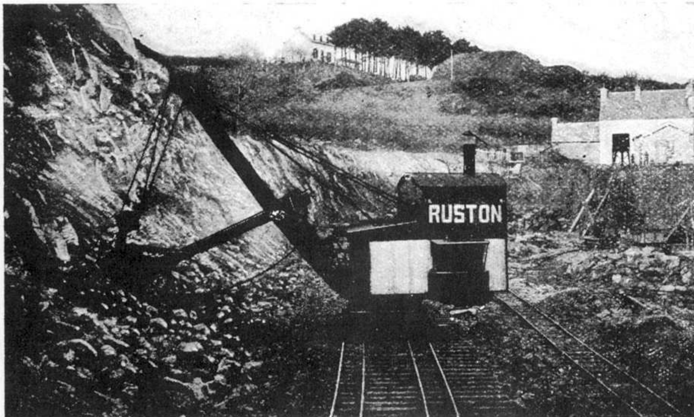
Un Excavateur à vapeur au travail dans une Carrière
