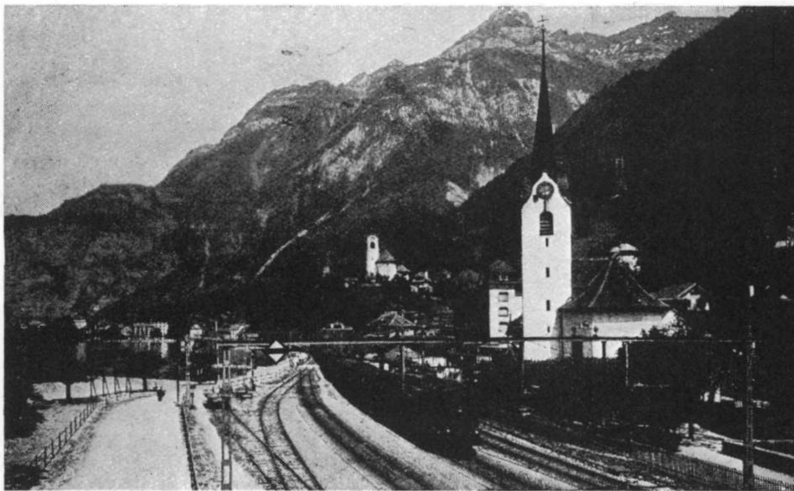
La Gare de Fluen sur la Ligne du St-Gothard.
