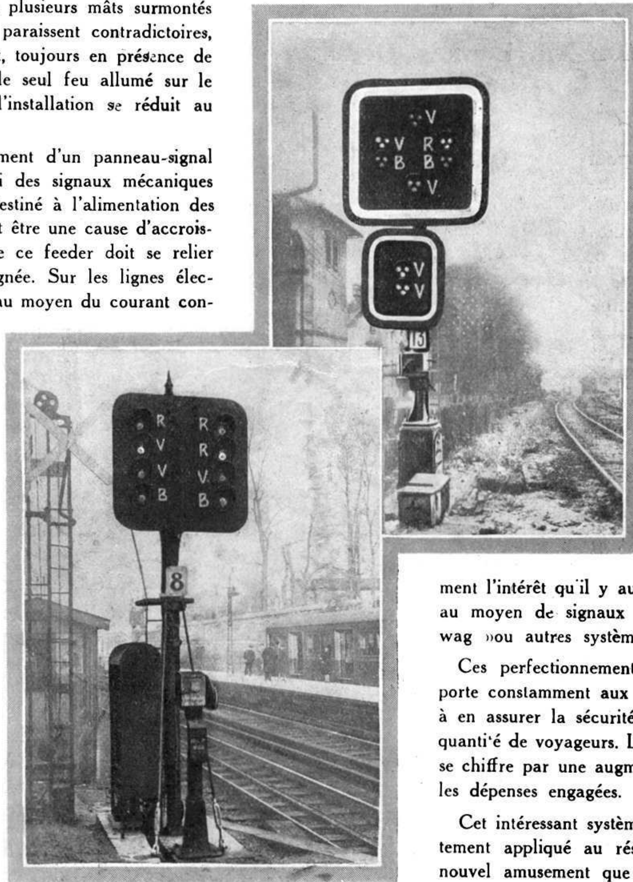
Système de signaux Lumineux En haut: Système français à 3 lampes En bas: Système américain
