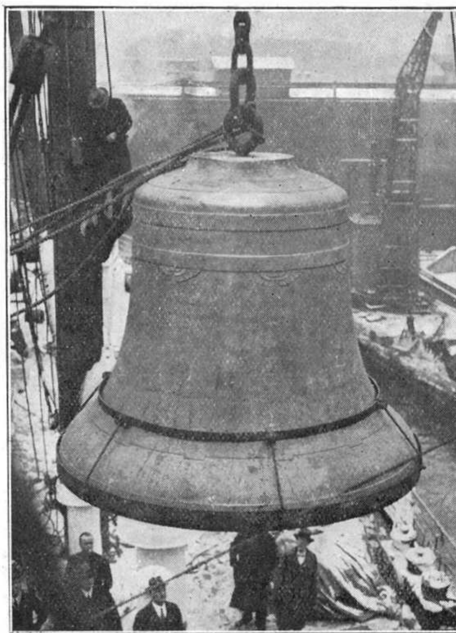
La Plus Grande Cloche de Monde (Naumacher Building à New-York) On est en train de hisser la cloche à 400 pieds au-dessus du Sol. Le poids de cette cloche géante est de 17.000 kilogrammes, son Diamètre de 2 m. 85, la portée de son est d'environ 45 kilomètres
