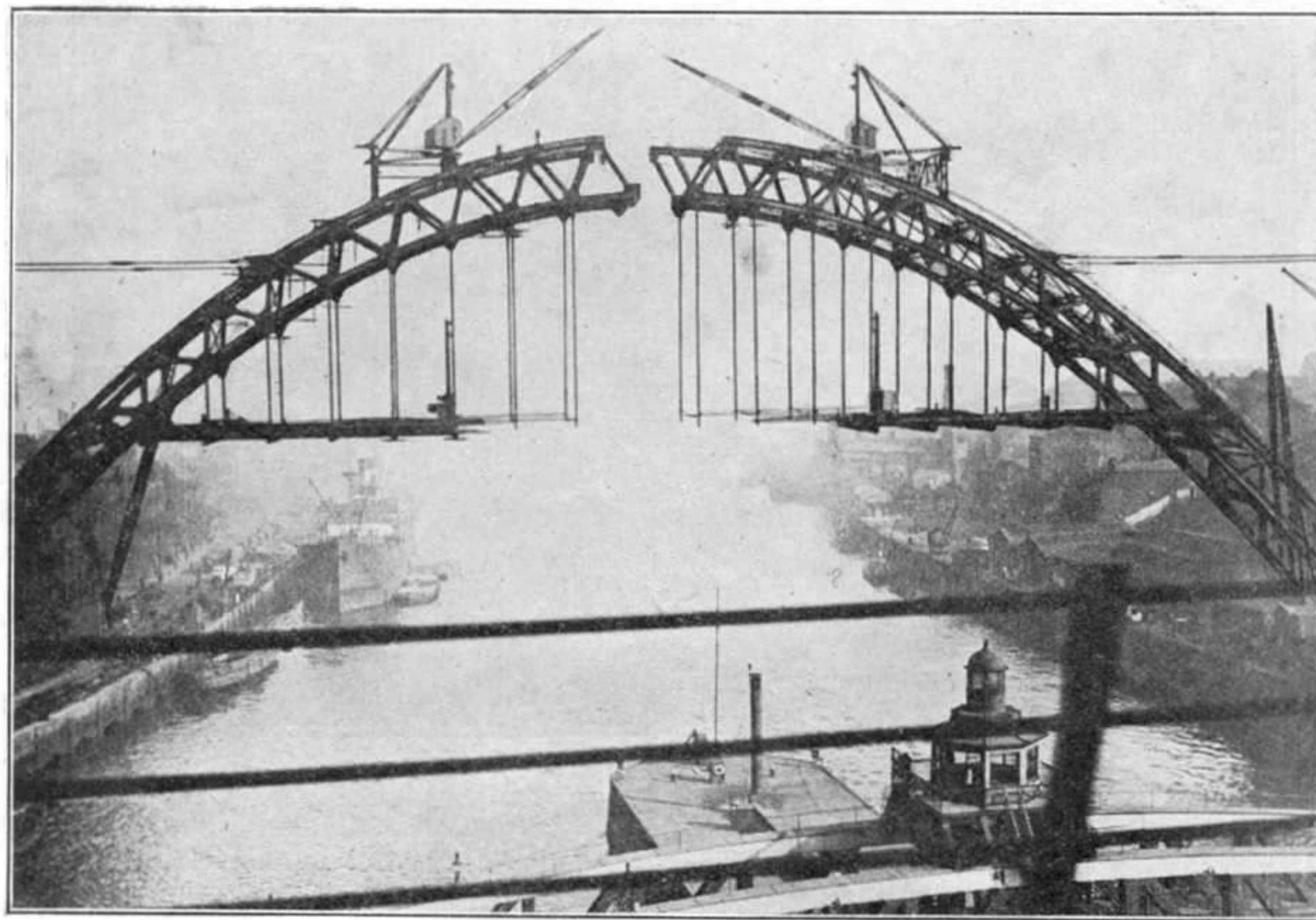
Ce pont est en voie de construction sur le Tyne entre Newcastle et Gateshead. Sa longueur atteint 230 mètres et il reviendra au prix de un million de livres, soit environ cent vingt cinq millions de francs.
