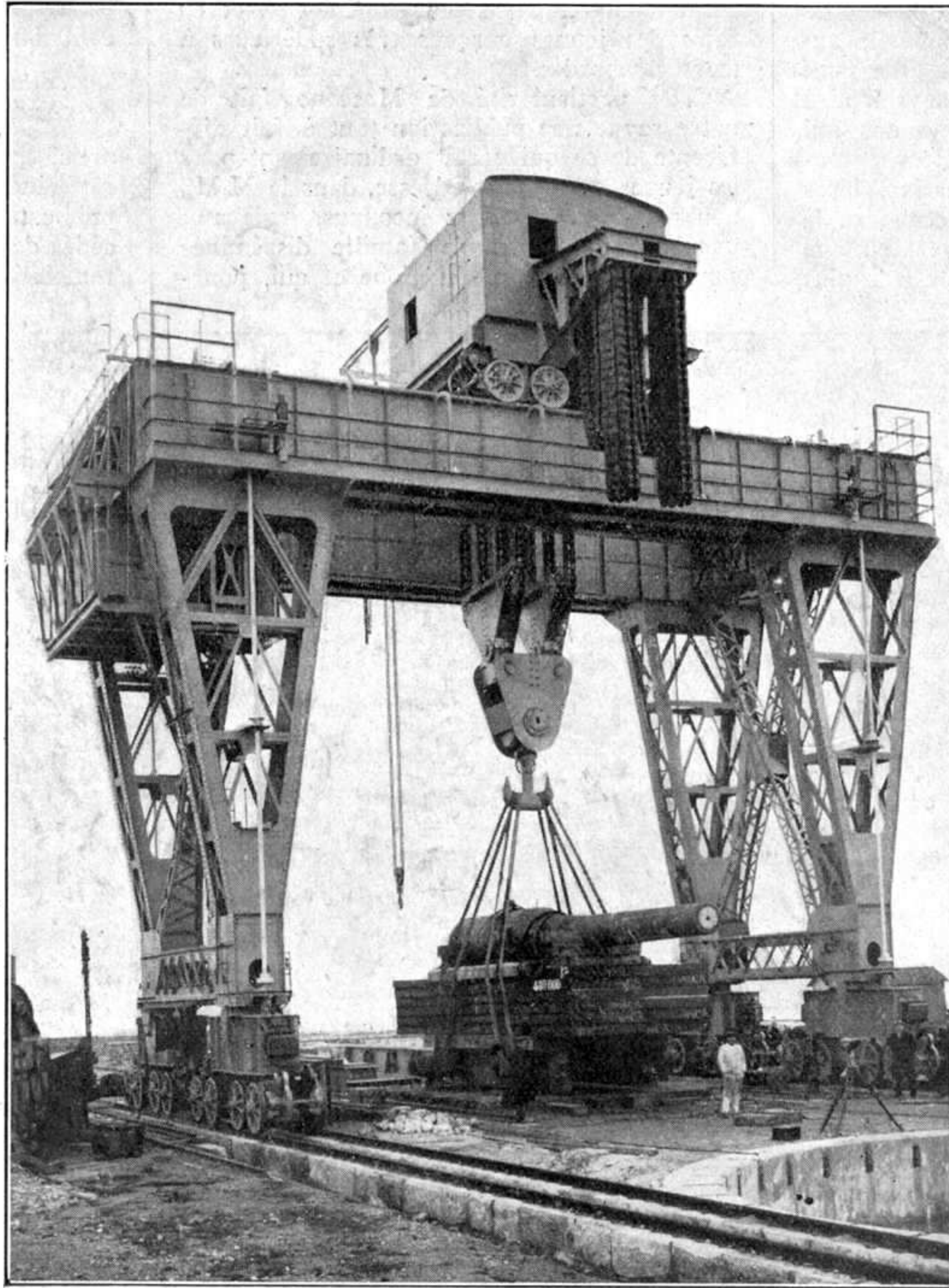
La Grue de 480 tonnes en cours d'Essais
