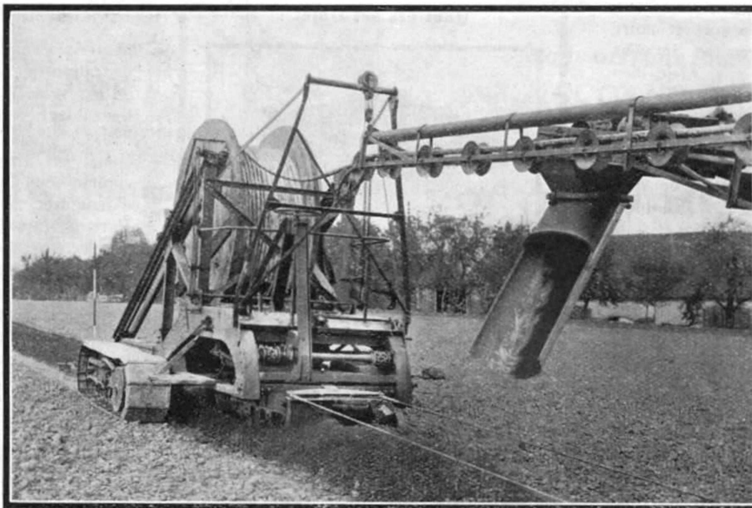
II. — Vue partielle de la Machine prise de l'avant et montrant le véhicule porteur du câble, le système de galets sur lesquels passe le câble et la verseuse comblant la tranchée.
