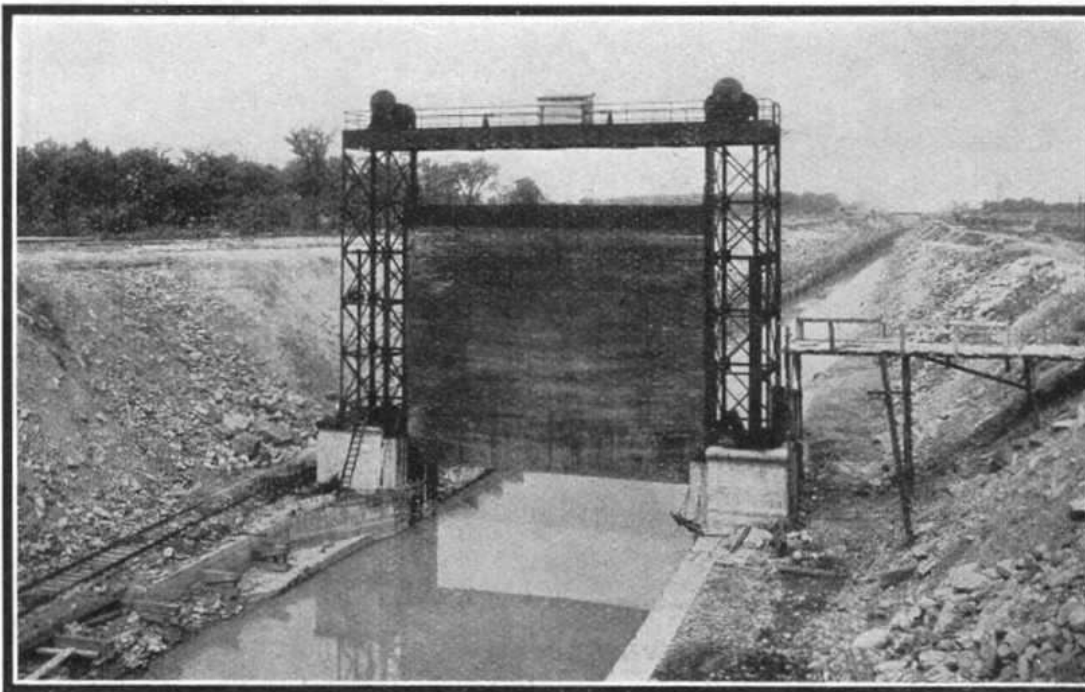
La Grande Vanne du Canal
