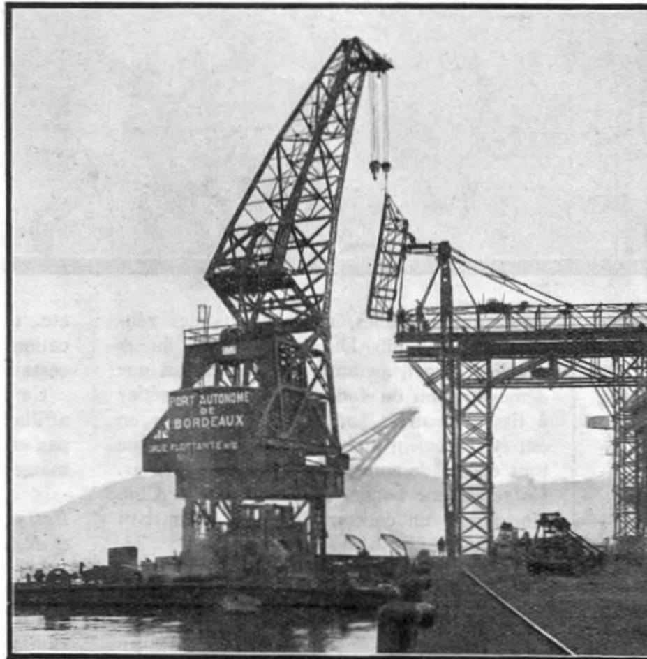
**Grue flottante automotrice de 30 tonnes de puissance**
