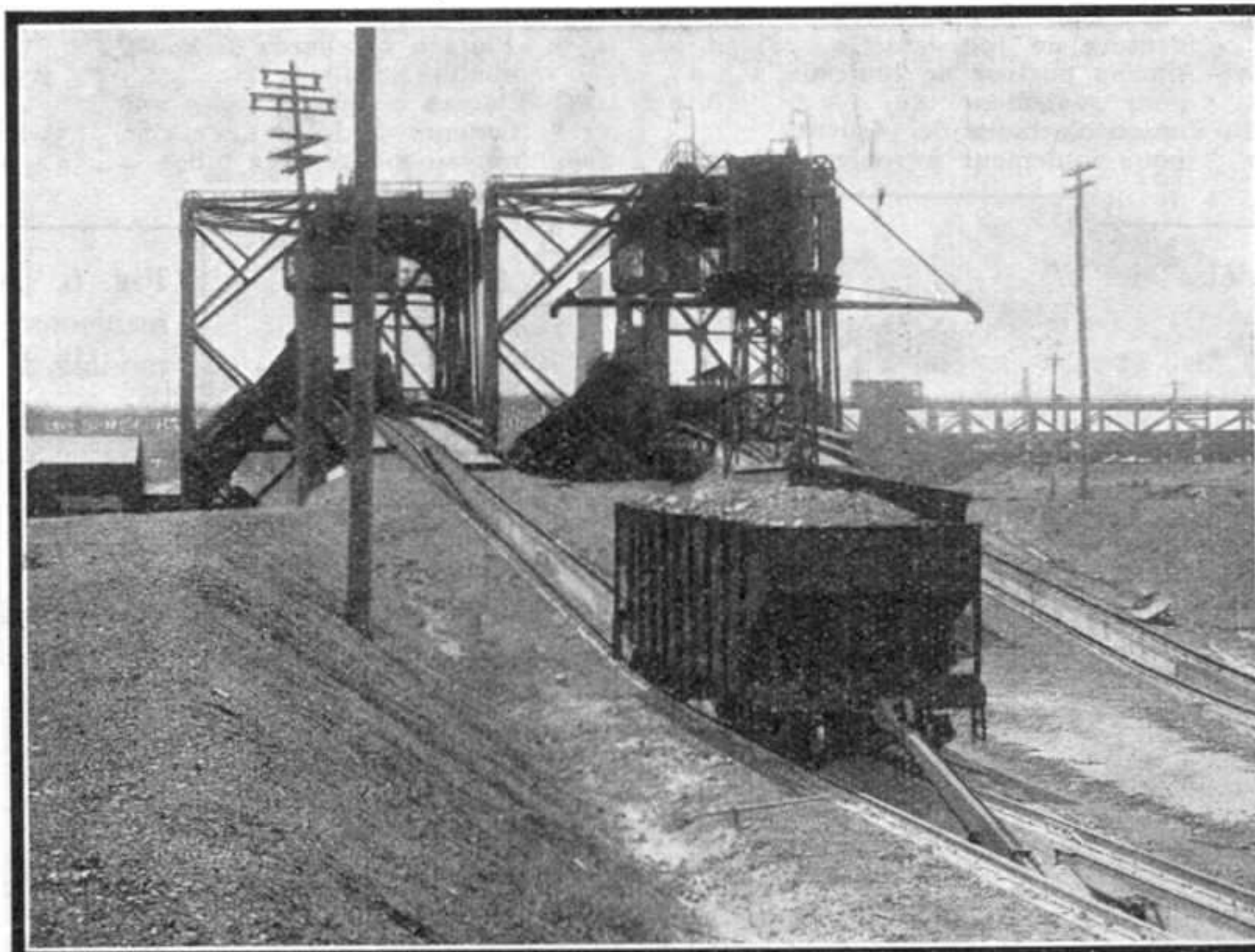
Wagon poussé par un bras mécanique vers les culbuteurs
