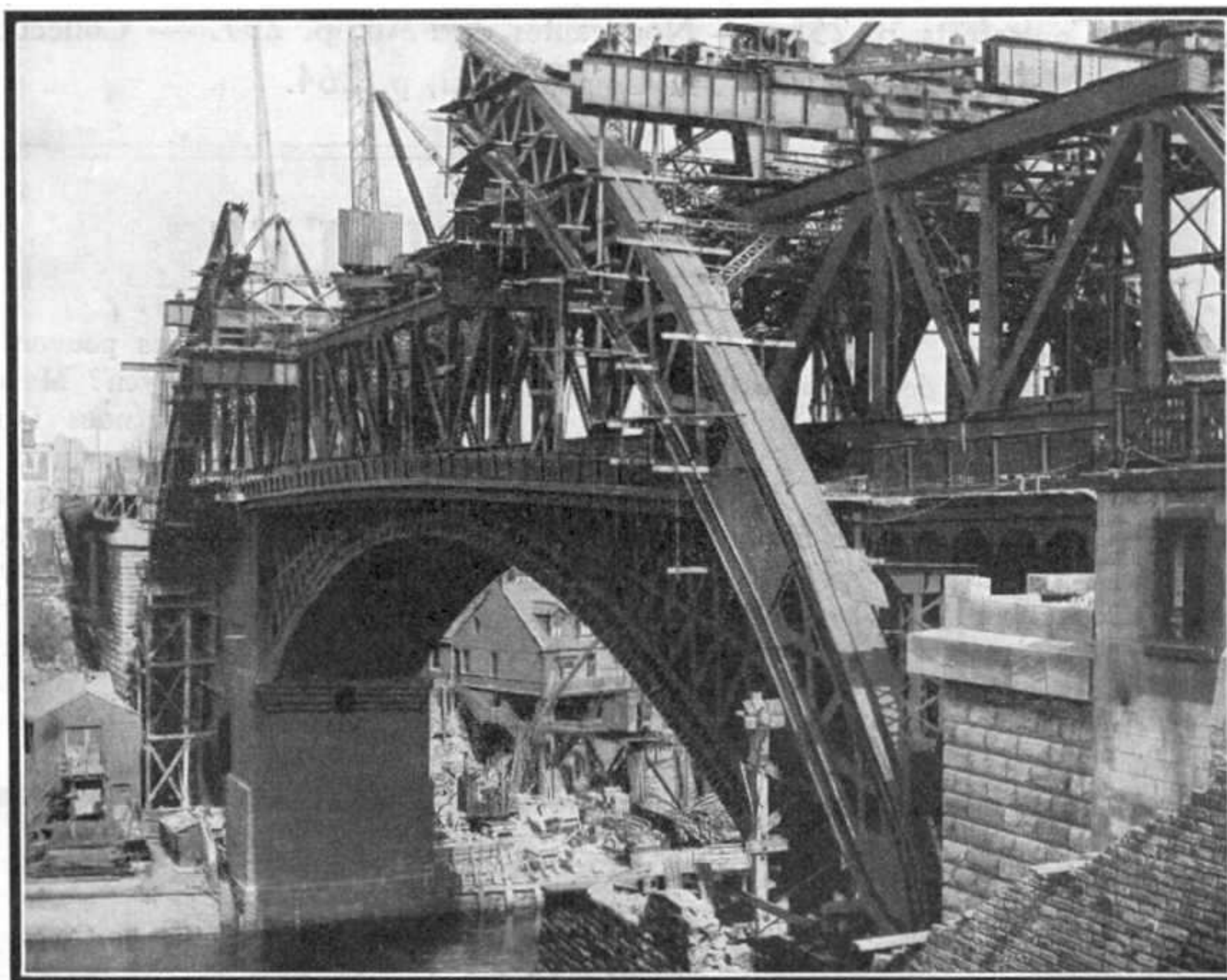
Vue du Pont de Sunderland sur l'embouchure du Wear, prise pendant sa construction.
