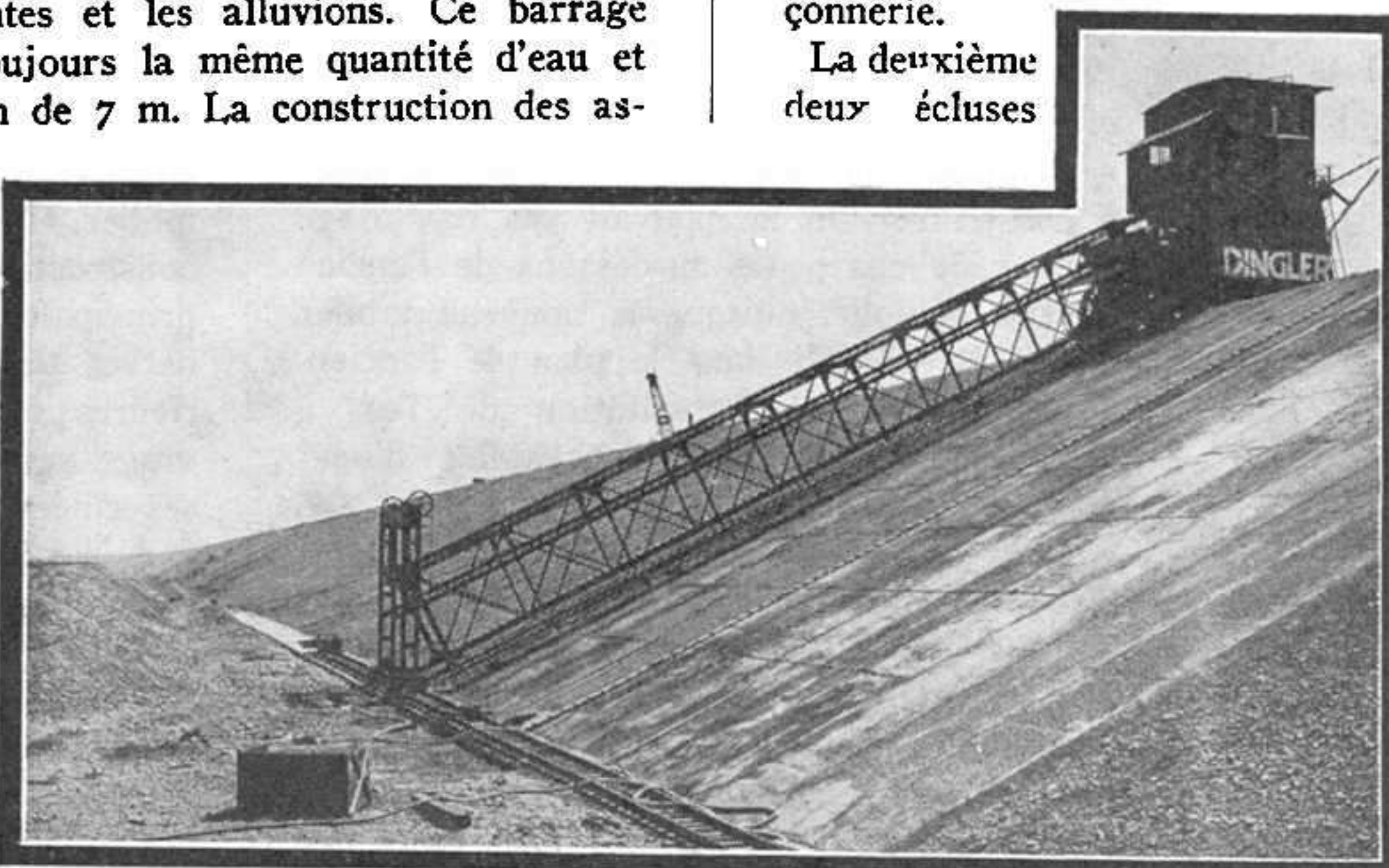
Fig. 2. Le long du canal d'aménée. — Bétonneuse Dingler.
