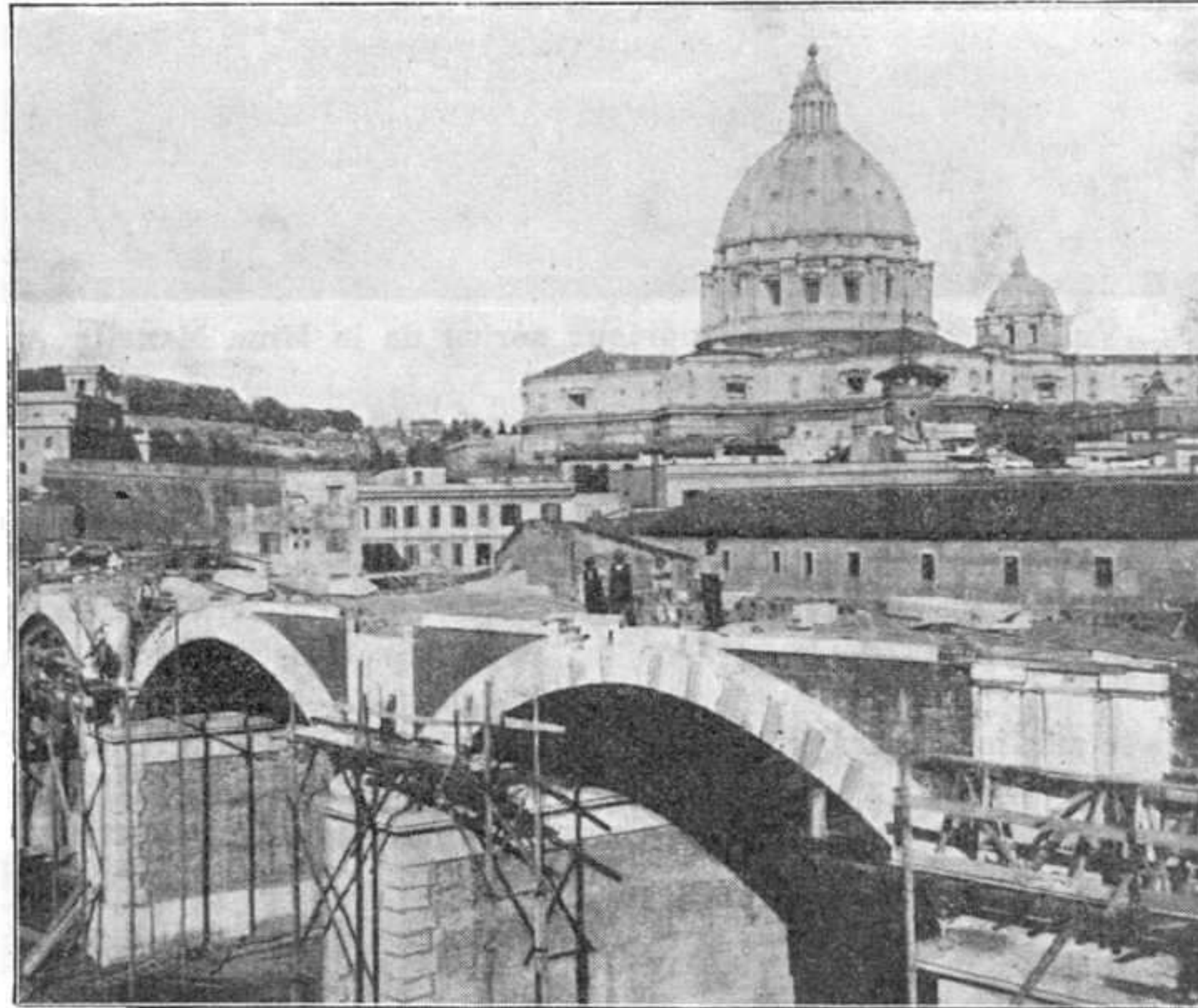
Vue prise pendant la construction du Viaduc.
