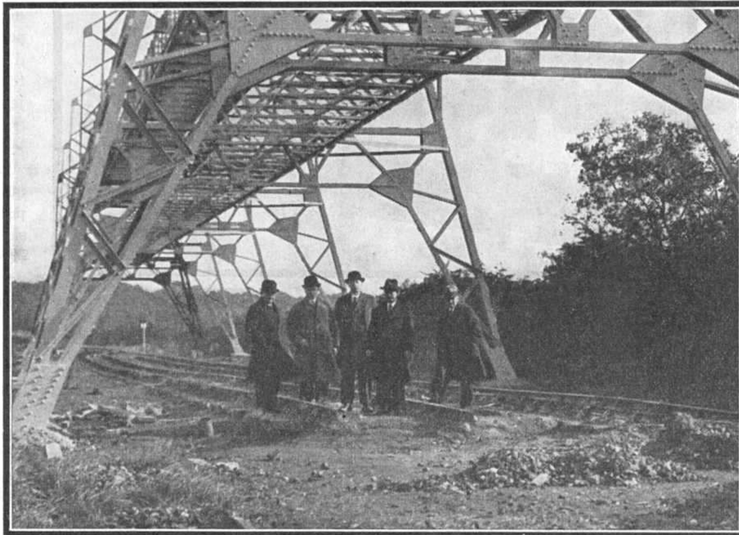
Les deux gravures de cette page représentent des vues de la ligne aérienne construite à Milngavie, près Glasgow.
