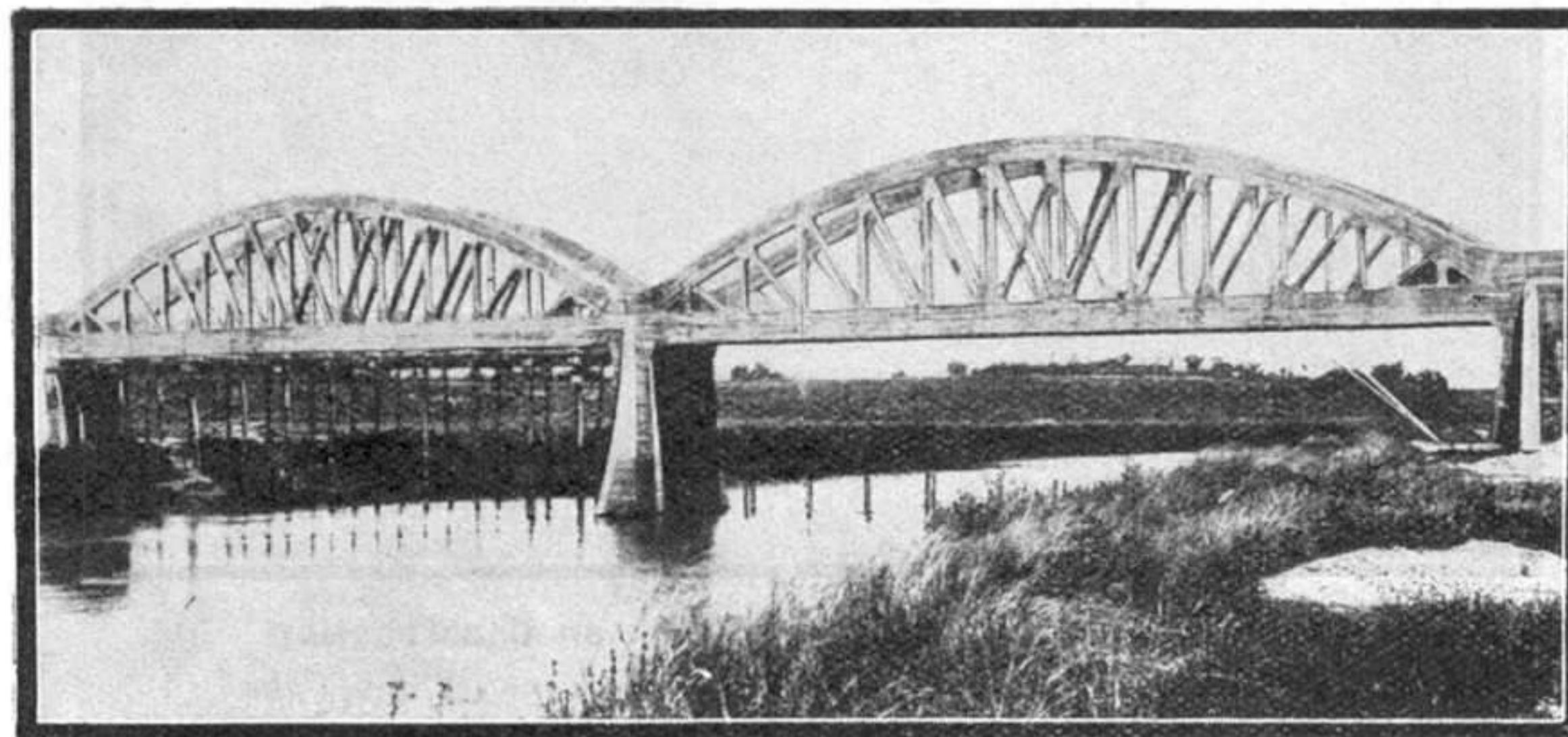
Pont en Béton armé sur l'Ihazolava Longueur 80 mètres. Les deux travées centrales ont 32 m. 50 chacune
