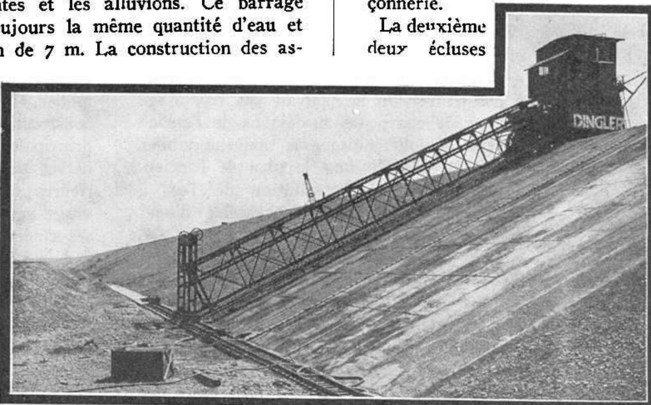
Fig. 2. Le long du canal d'aménée. — Bétonneuse Dingler.
