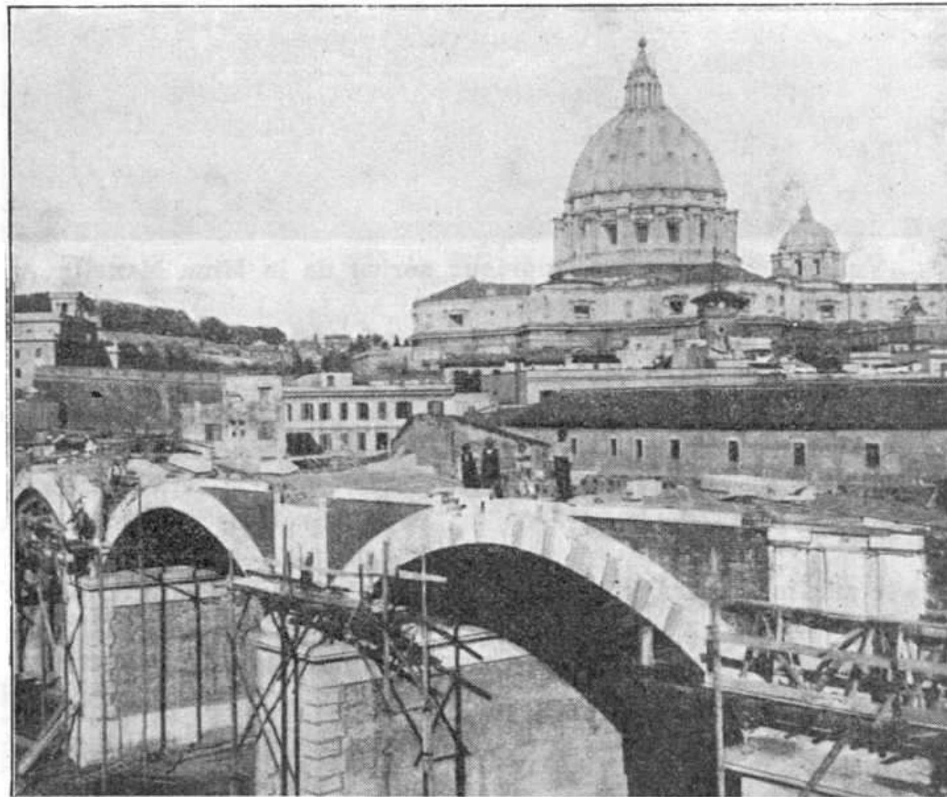
Vue prise pendant la construction du Viaduc.
