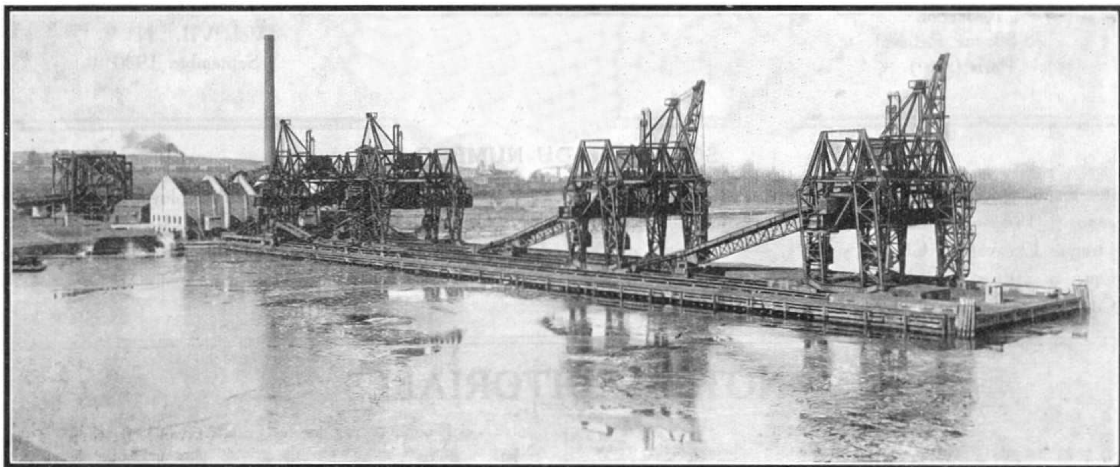
Vue générale de la jetée du port de Baltimore avec ses chargeurs de charbon.
