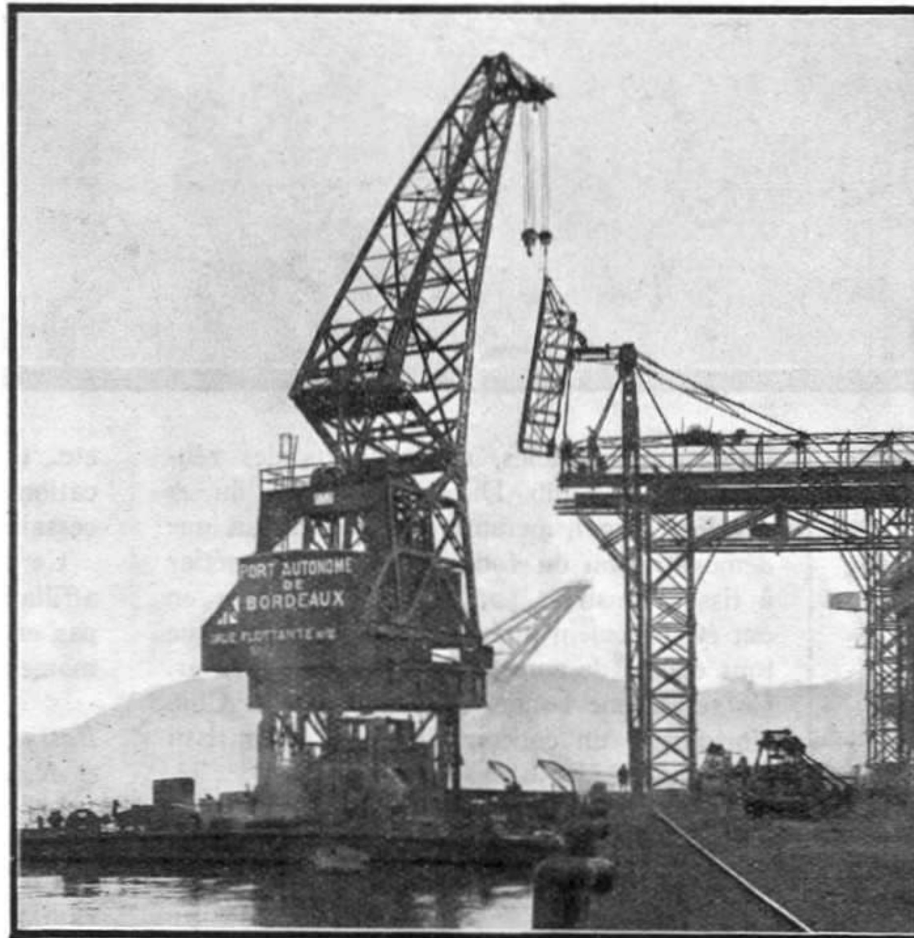
Grue flottante automotrice de 30 tonnes de puissance A l'arrière-plan, grue de 250 tonnes des Chantiers de la Gironde
