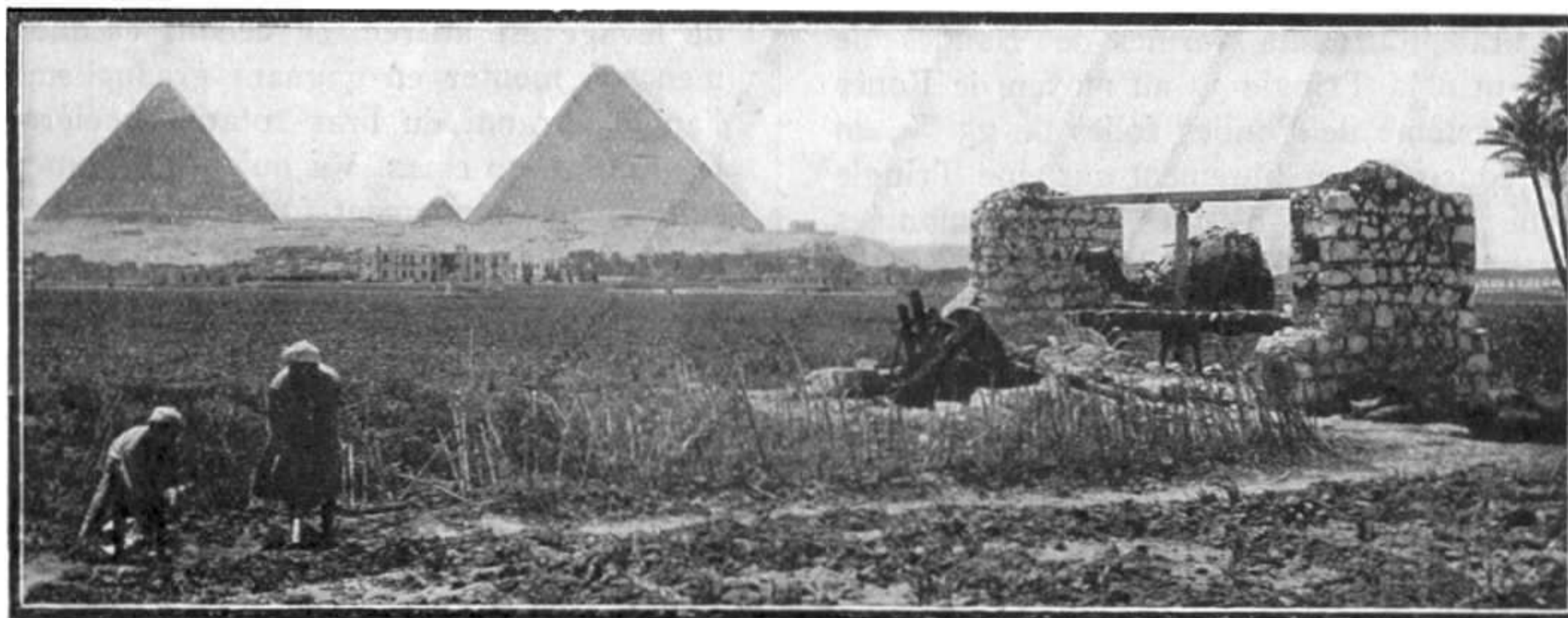
L'irrigation des champs égyptiens s'effectue encore de nos jours par les mêmes procédés qu'il y a des milliers d'années. Des chameaux ou des bœufs tournent de grandes roues en bois qui font monter l'eau dans des récipients en terre cuite.
