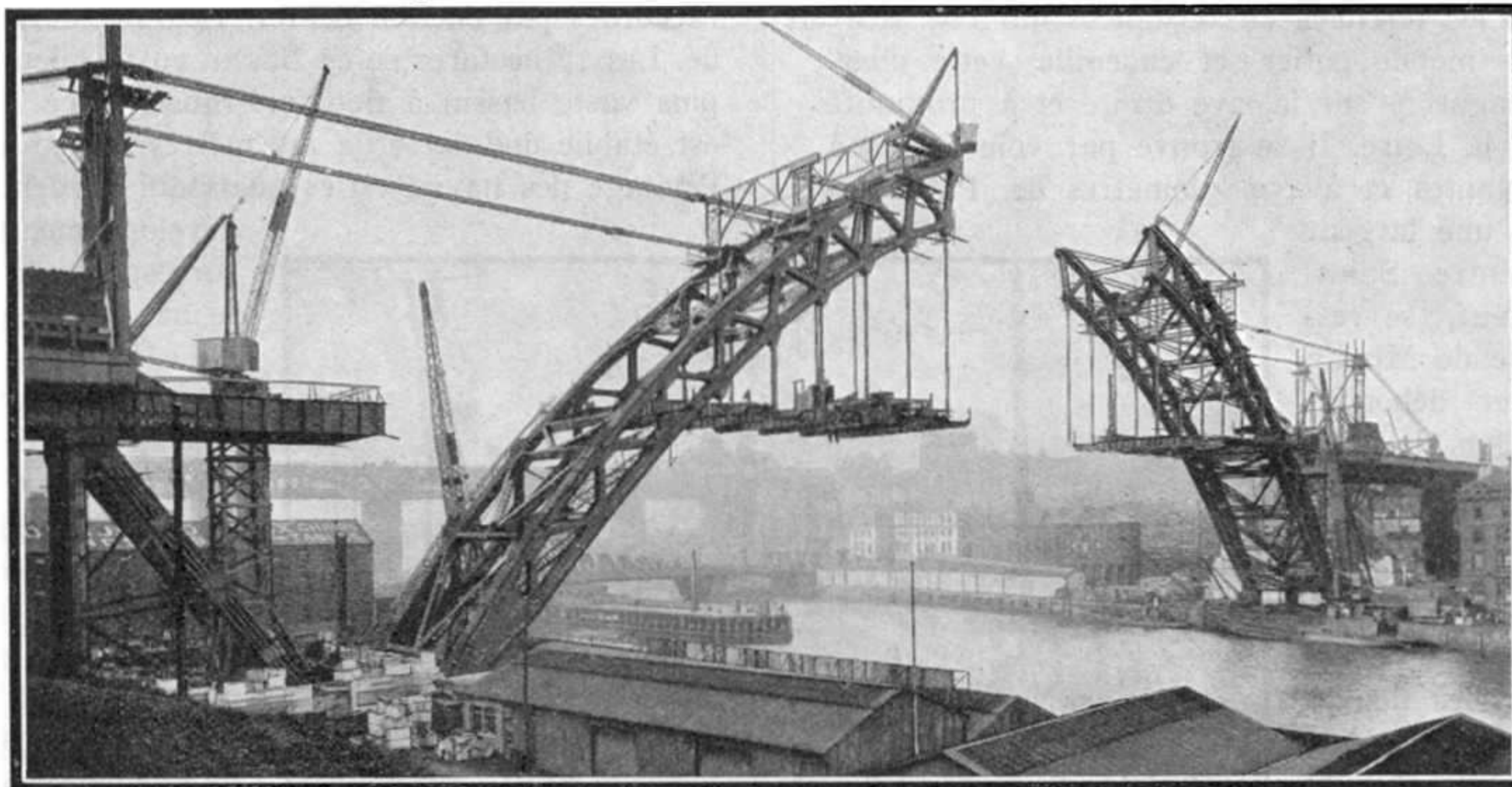
Le Pont sur le Tyne en cours de construction.
