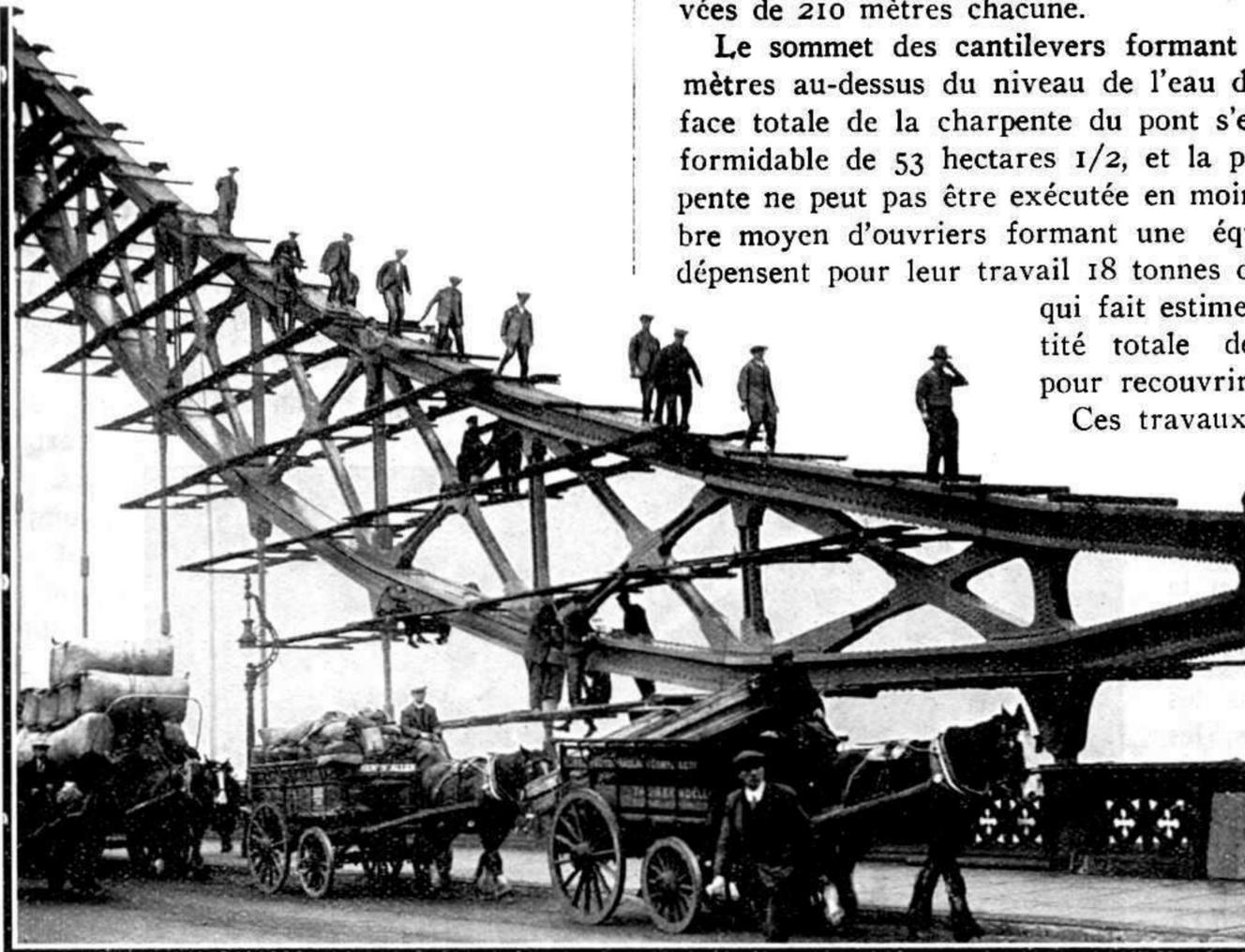
Echafaudage installé pour la peinture de l'une des chaînes de suspension du Tower Bridge de Londres. Comme le montre la gravure, une adresse réellement acrobatique est nécessaire pour l'exécution de ce travail.
