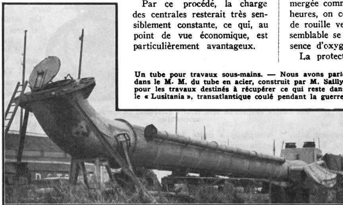
Un tube pour travaux sous-mains. — Nous avons parlé dans le M. M. du tube en acier, construit par M. Sully, pour les travaux destinés à récupérer ce qui reste dans le « Lusitania », transatlantique coulé pendant la guerre.
