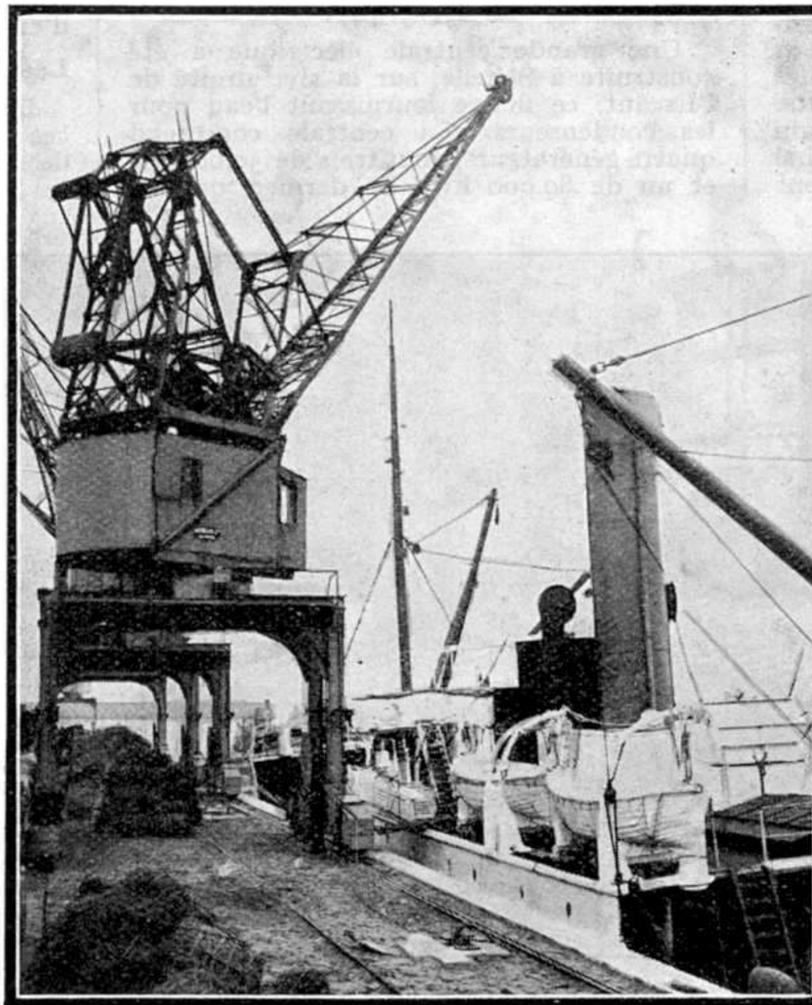
Une des six grues de 3 tonnes à fèche relevable installées sur le Quai Wilson de Nantes.
