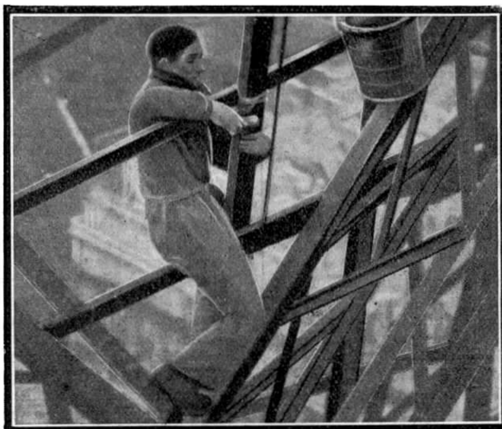
L'installation électrique de l'horloge à 200 mètres au-dessus du sol a comporté des travaux très difficiles. Les ouvriers, auxquels cette installation a été confiée, ont dû être de vrais acrobates et ne pas craindre le vertige.
