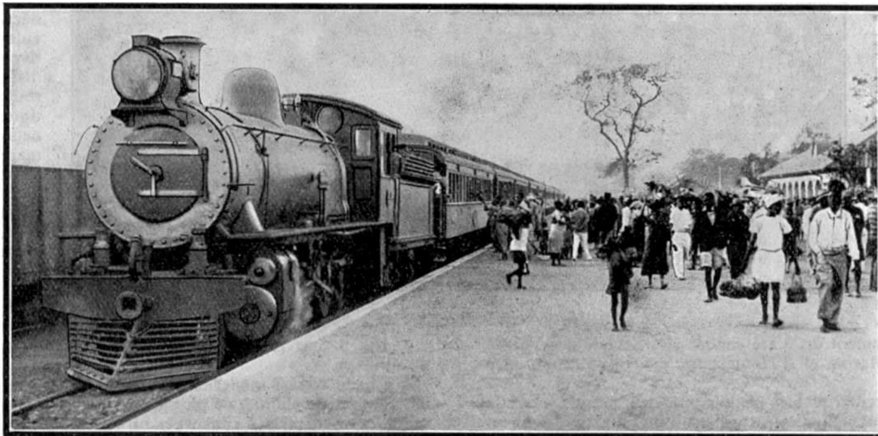
A l'heure actuelle, le Chemin de fer de Beira a un aspect moderne digne de tout pays civilisé ; sur la photo ci-dessus : l'arrivée du train à la station de Broken Hill, en Rhodésie. Les clichés que nous reproduisons sur ces deux pages nous ont été prêtés par la Compagnie des Chemins de fer de Rhodésie.
