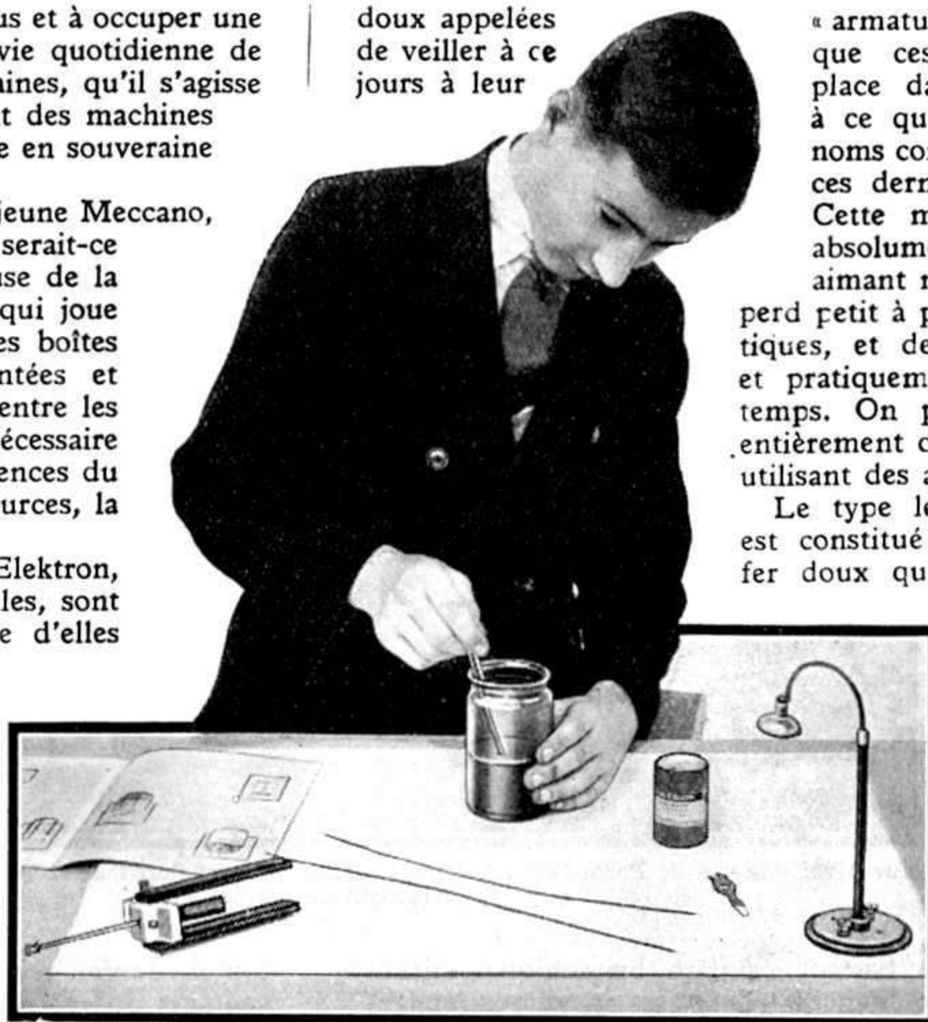
Fig. 2. — Préparation de la solution au bichromate de potassium pour la Pile Elektron. Toutes les autres pièces nécessaires pour l'expérience se trouvent sous la main sur la table.
