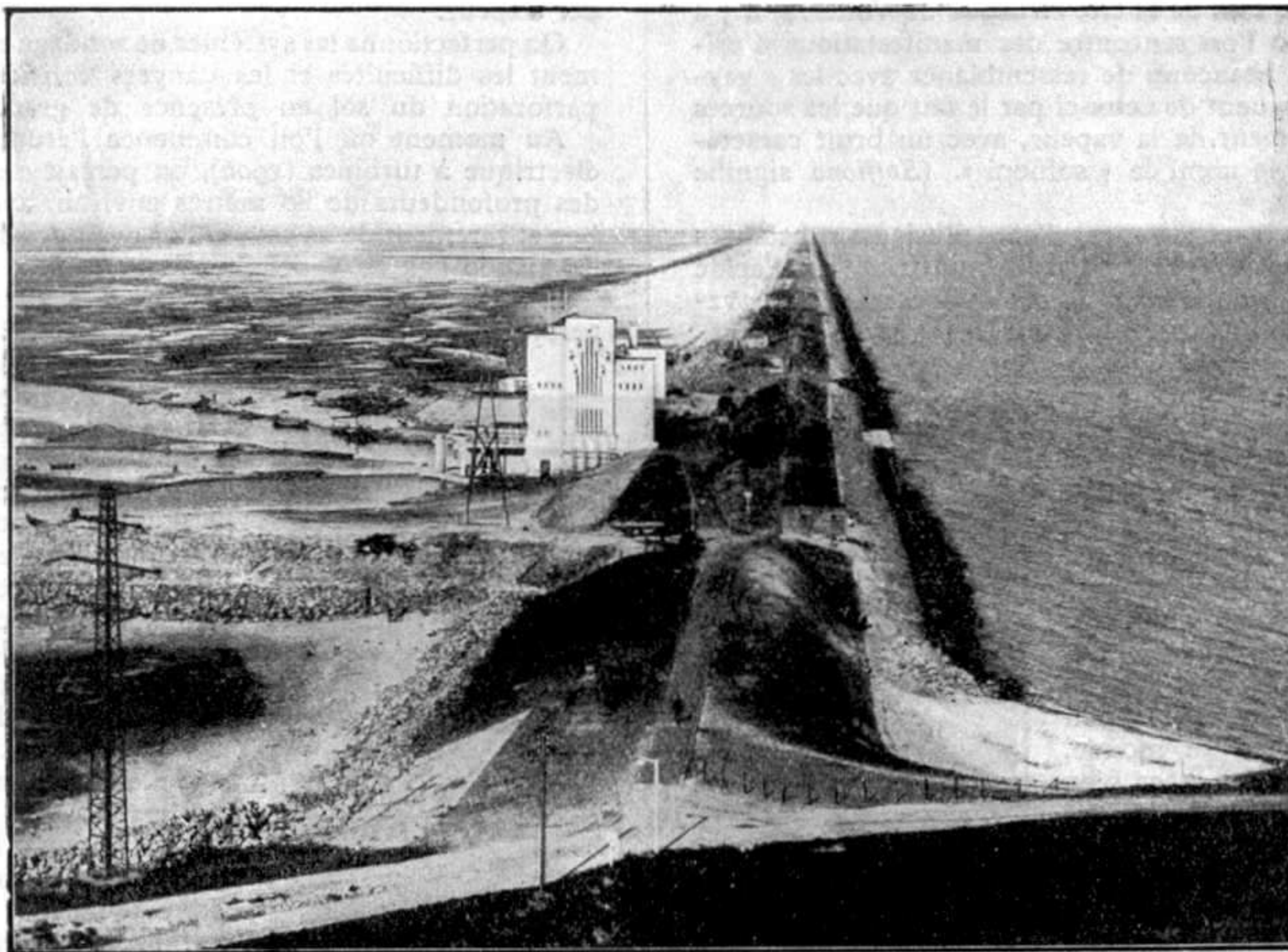
Vue d'une des stations de pompage (station de Lely, près de Medemblik). A gauche, le polder; à droite, le Zuyderzée
