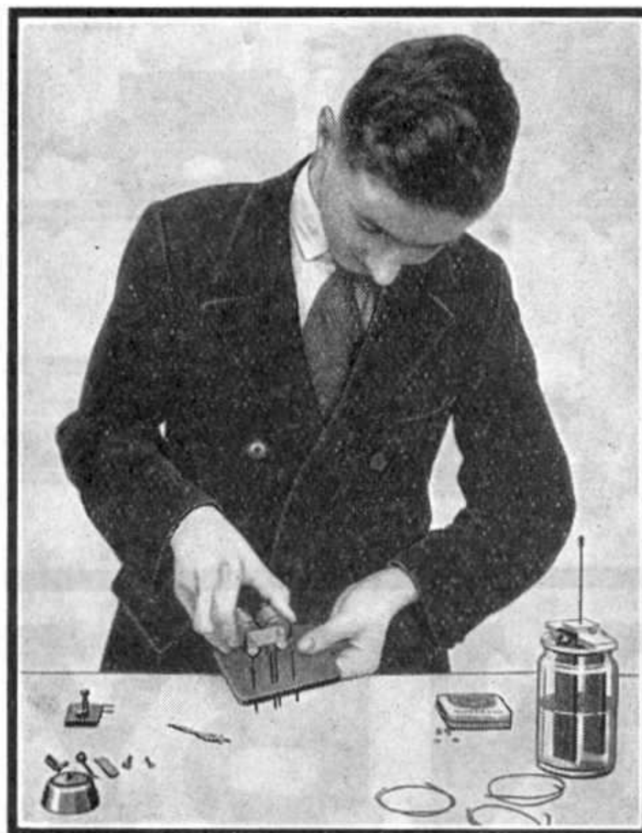
Montage de l'électro-aimant pour la Sonnette électrique.
