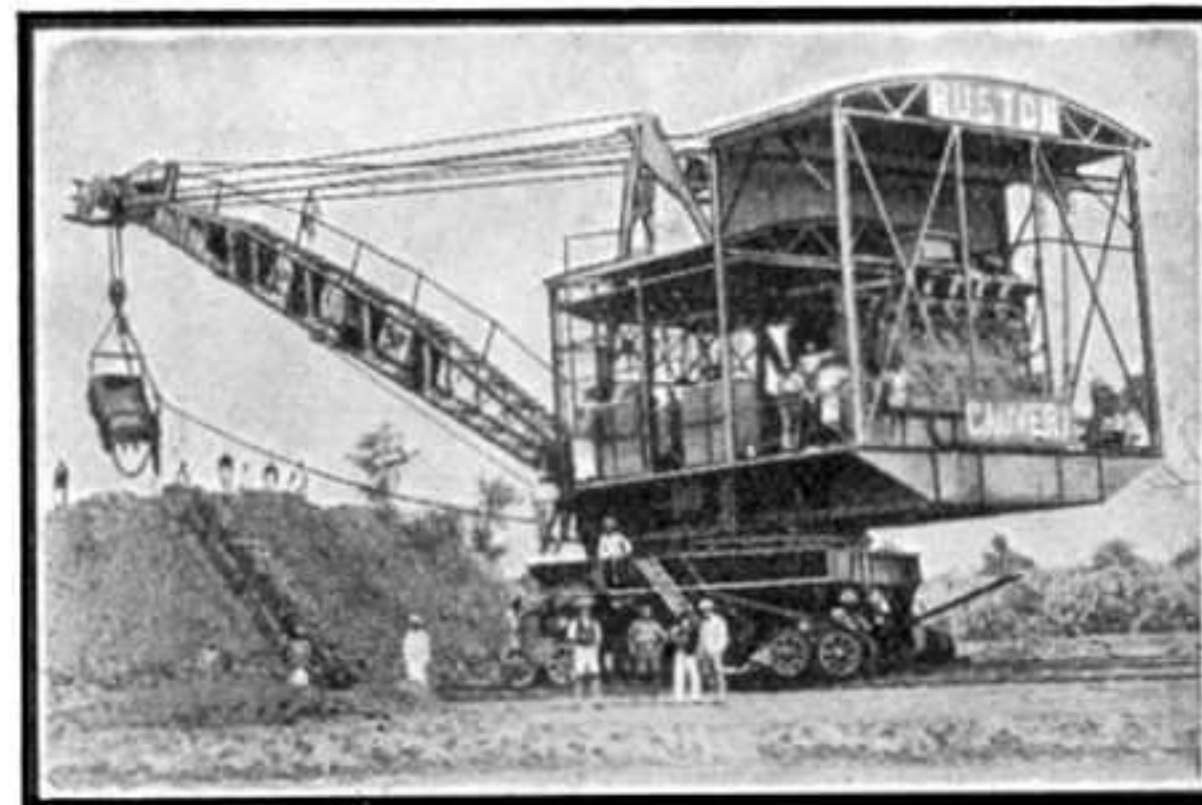
Drague excavatrice vue d'arrière,
