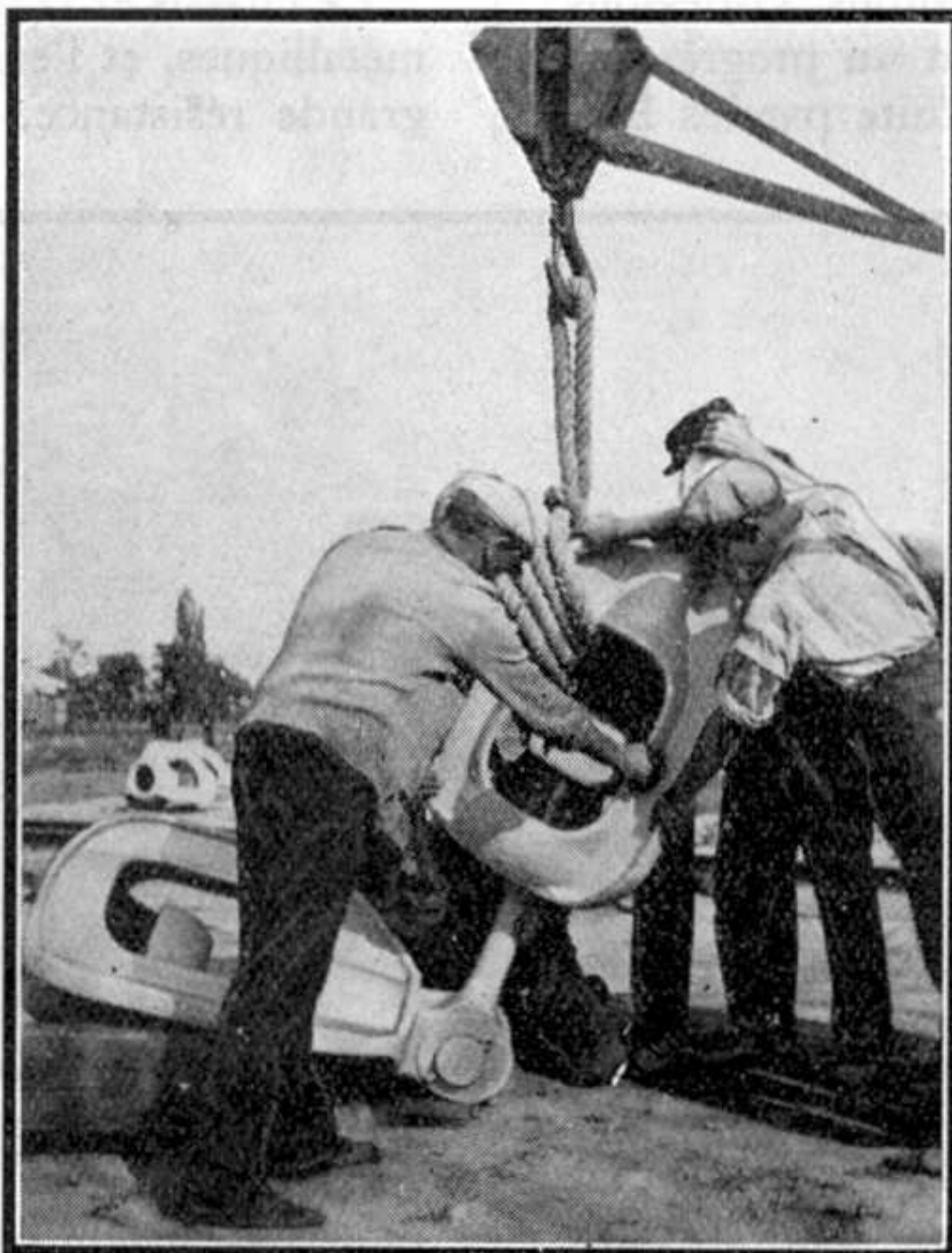
Montage de l'un des énormes isolateurs situés sur les câbles d'acier par lesquels le pylône est fixé à terre.
