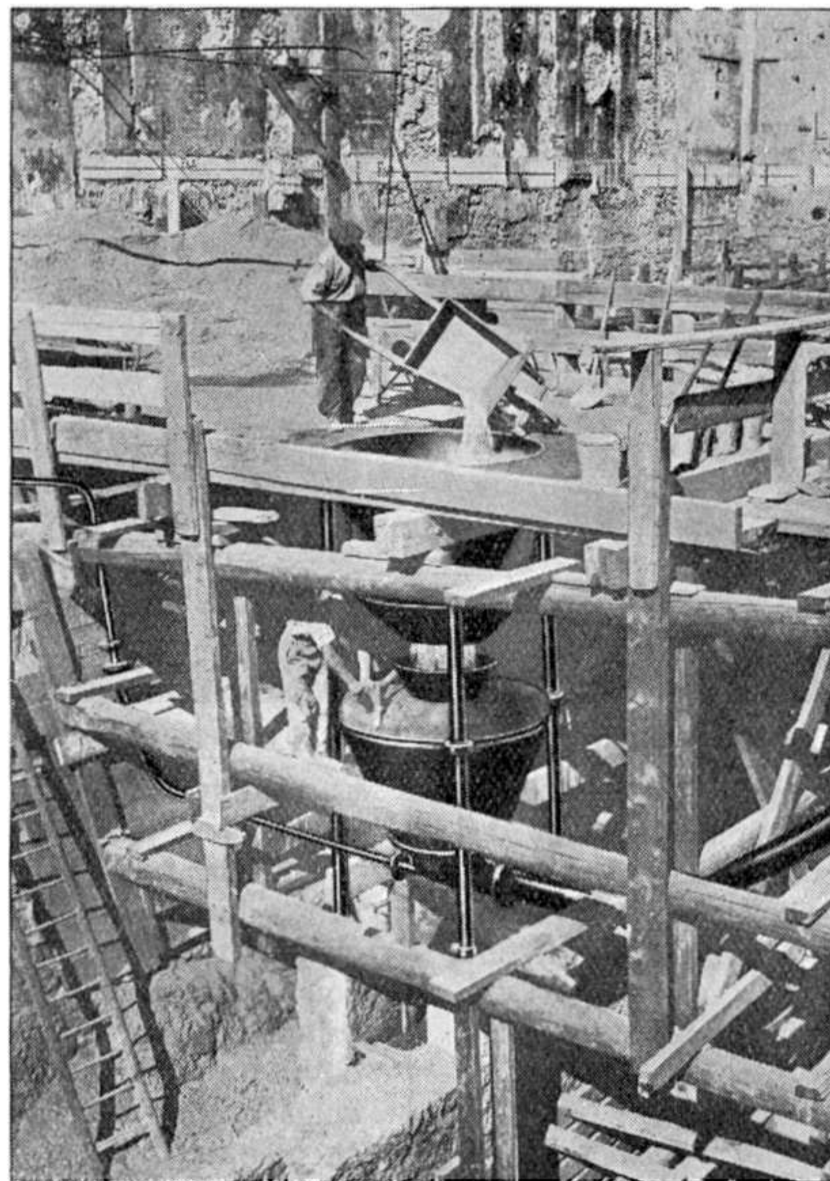
Transporteur pneumatique de béton installé sur un chantier parisien. L'appareil comprend deux trémies (dont une de chargement et l'autre de brassage) et un réservoir sous pression. Le mélange est évacué à la base par une tubulure que l'on voit à droite sur le cliché ci-dessus. L'air comprimé, qui envoie le béton dans cette tubulure de distribution, arrive par le tuyau que l'on voit à gauche. Cet appareil peut transporter jusqu'à 20 tonnes de béton à l'heure. La documentation pour cet article nous a été prêtée par la Compagnie Parisienne de l'Air Comprimé.
