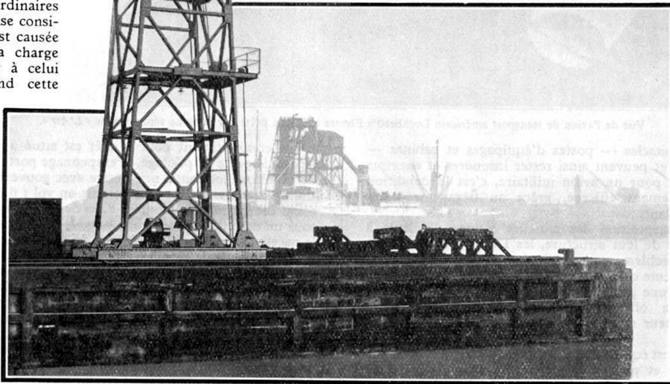
Une des 37 grues électriques en service dans les docks de Middlesborough, Angleterre. Photographie de la British Thomson-Houston C o Ltd.
