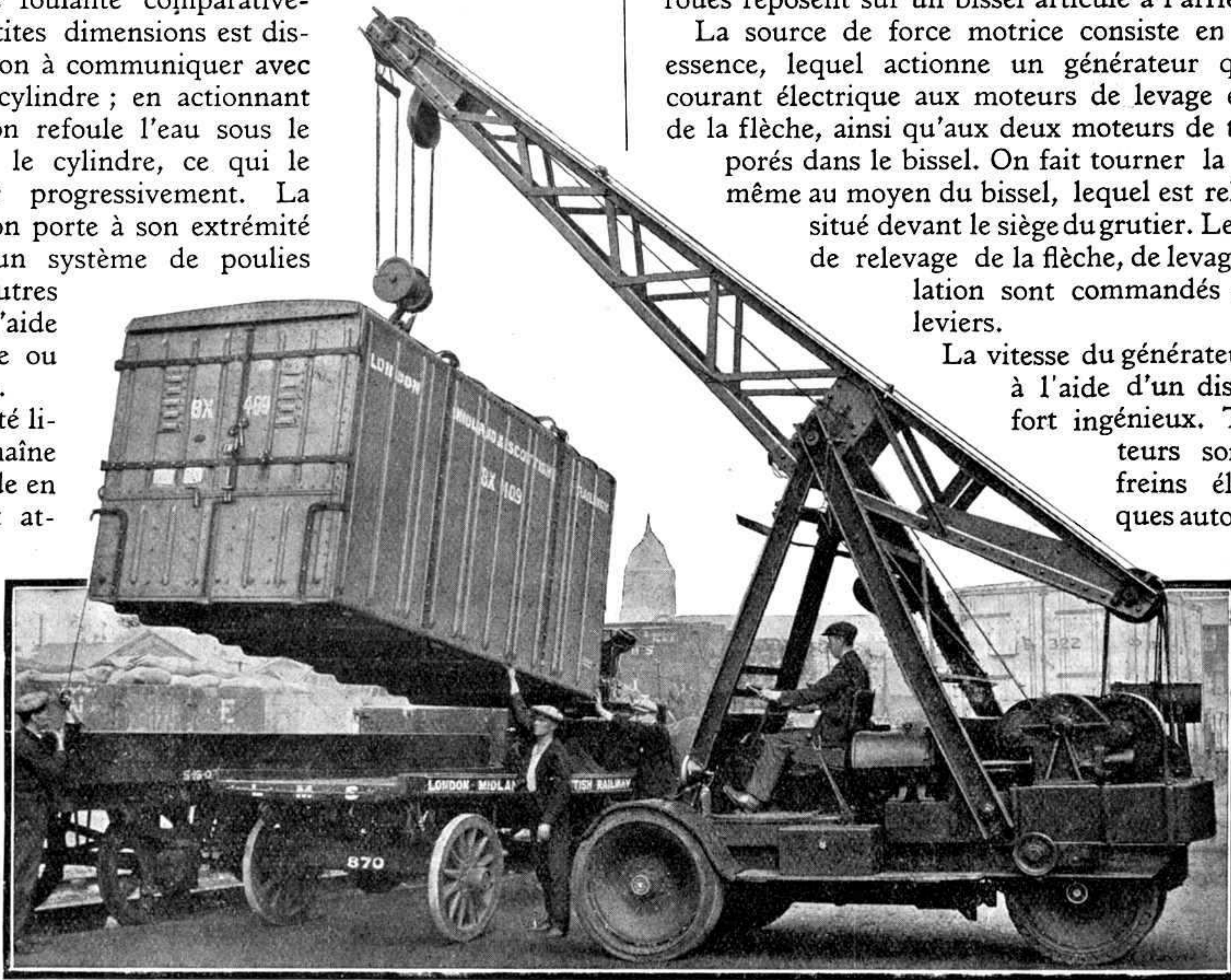
Grue mobile électrique manipulant une charge volumineuse.
