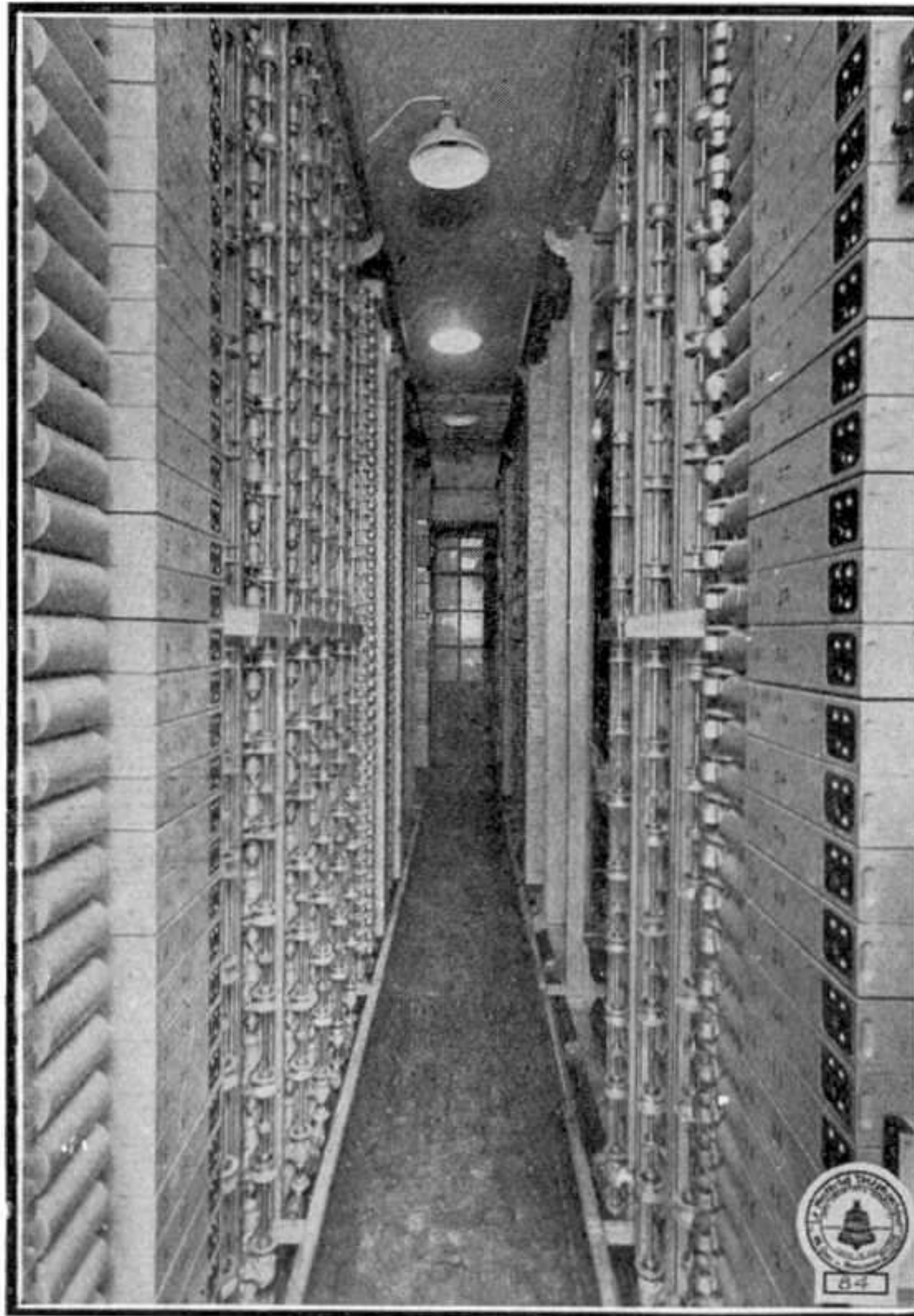
Un coin du labyrinthe de couloirs que représente un bureau central de téléphone automatique. La documentation que nous publions nous a été confiée par la Société « Le Matériel Téléphonique », à Boulogne-Billancourt.
