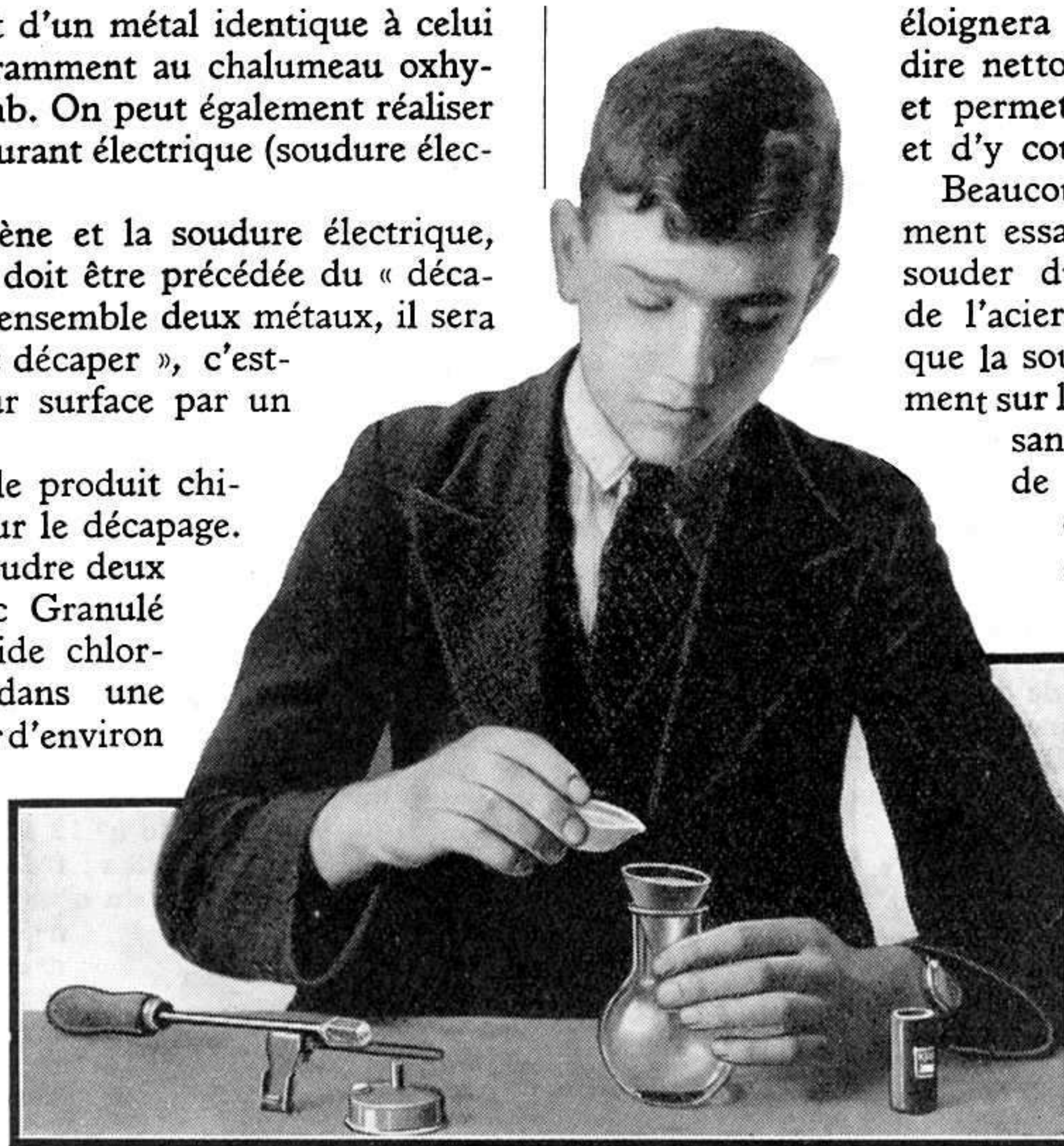
Fig. 2. — Filtrage de la solution obtenue par la dissolution du Zinc Granulé dans de l'acide chlorhydrique dilué. La solution de chlorure de zinc préparée ainsi sert à décaper les métaux pour le soudage.
