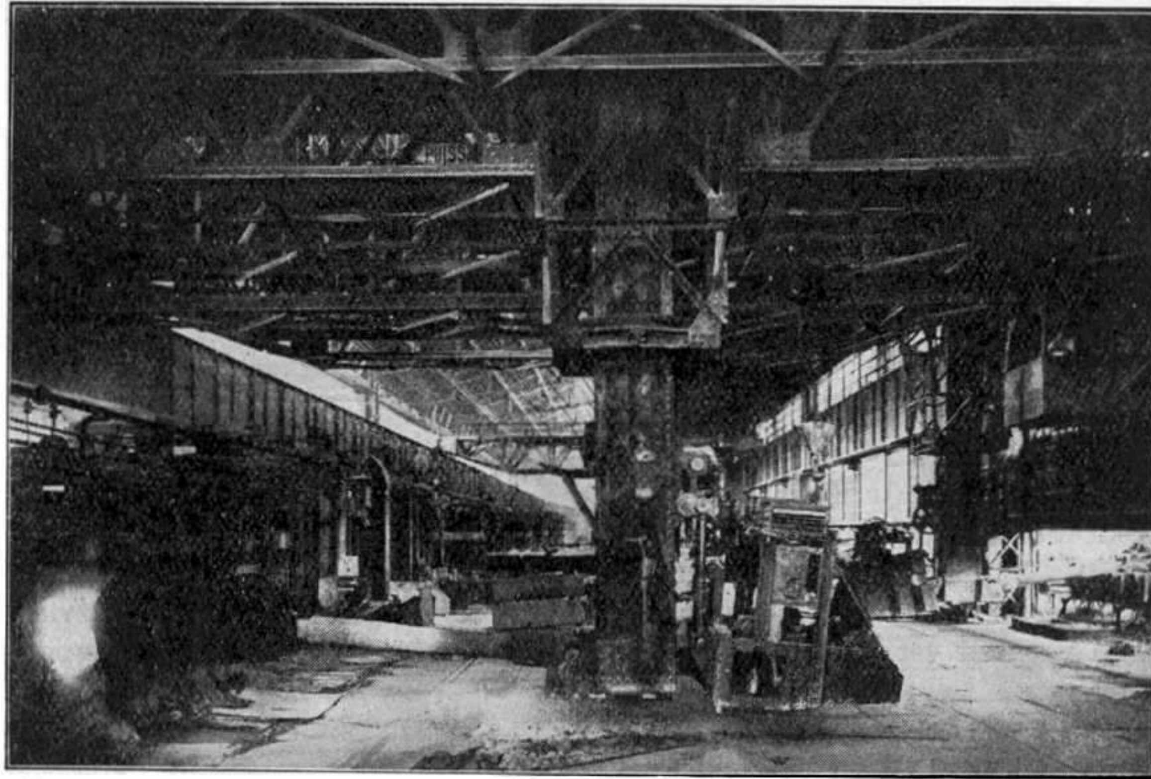
Chargement des fours Martin à l'usine du Breuil. La documentation que nous publions nous a été remise par les Etablissements Schneider et Cie.
