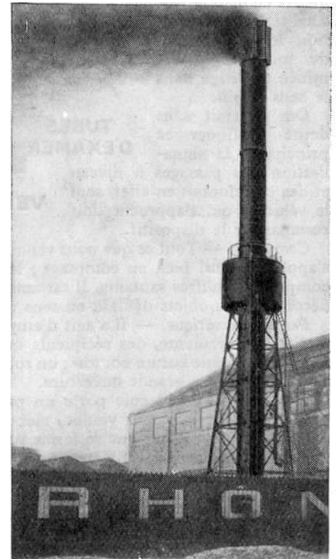
Un « Chanard-Etoile », monté sur une cheminée de fours à cuire, augmente considérablement le tirage, autrement insuffisant. Les clichés que nous publions nous ont été confiés par les Etablissements Chanard.
