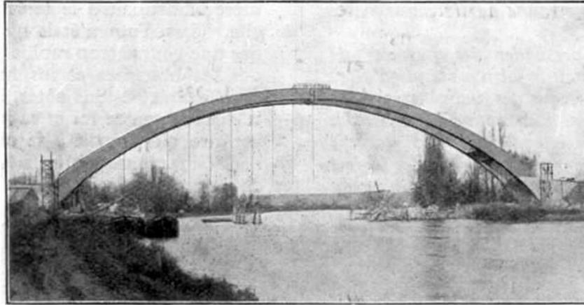
Pont sur la Seine à Saint-Pierre-du-Vouvray, construit par les Entreprises Limousin. La portée de ce pont est de 132 mètres.
