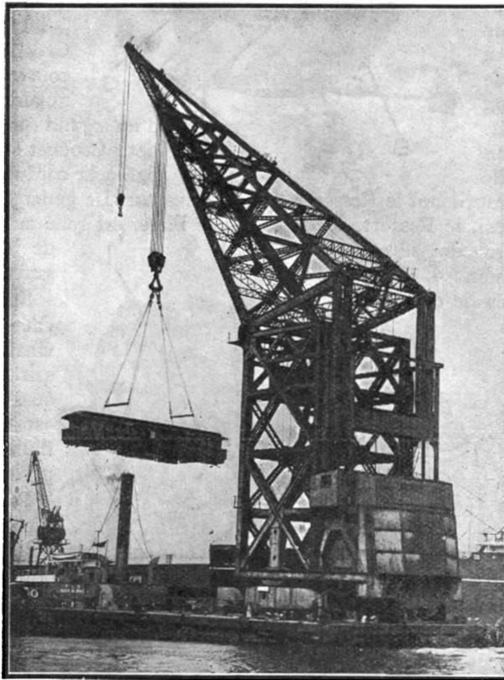
Grue flottante de 150 tonnes effectuant, dans le port de Londres, le chargement d'une voiture de chemin de fer destinée à l'Afrique australe.
