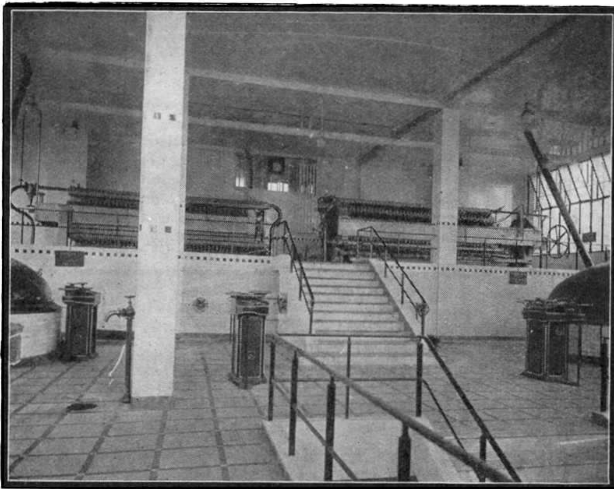
Salle de brassage des Brasseries de la Meuse, à Sèvres, avec, au fond, deux filtres à moût. Les filtres sont constitués par une série de plateaux en fonte séparés par des toiles en coton. Le moût trouble y laisse la drêche.
