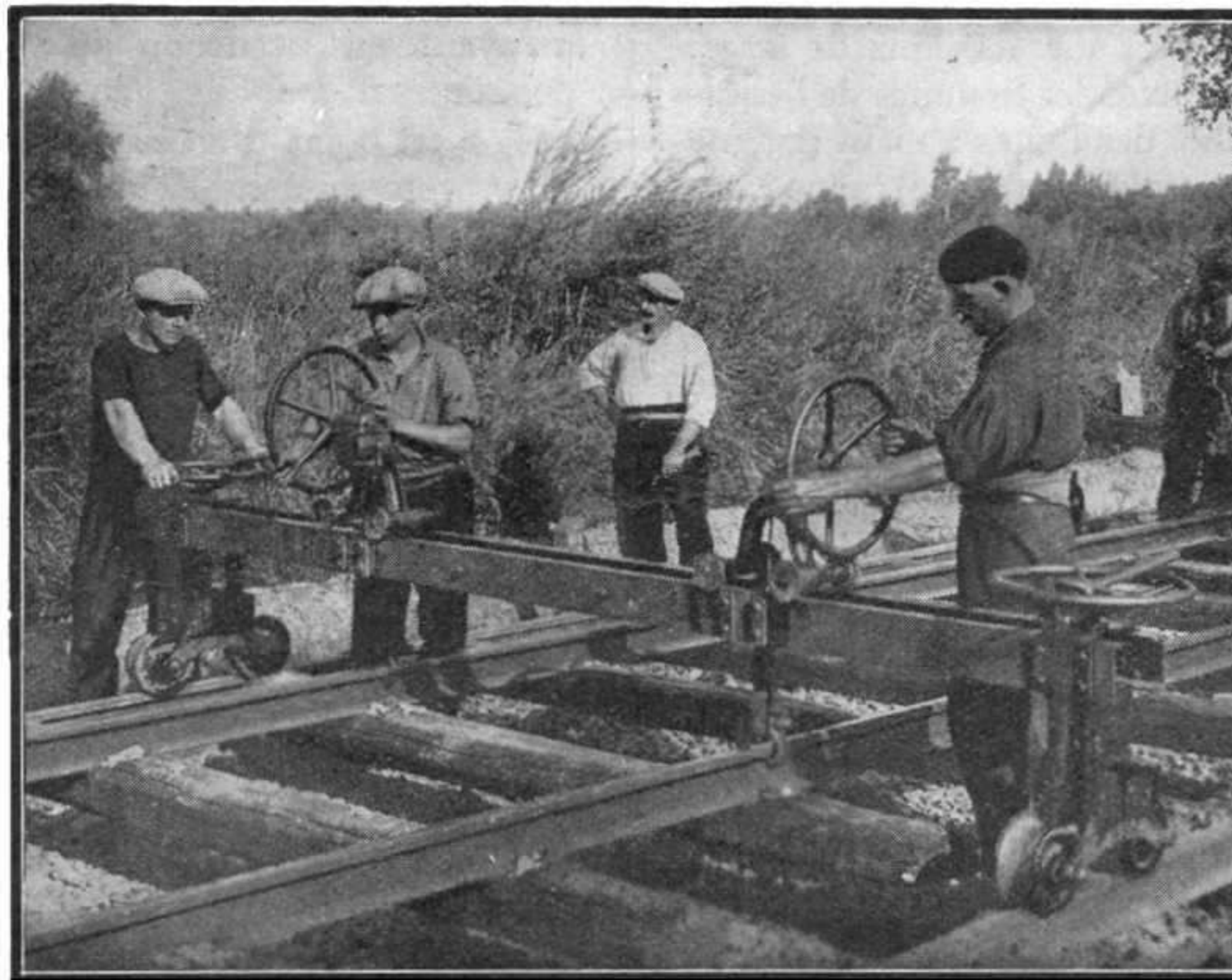
Portique circulant sur voie de travaux et supportant un tronçon de voie tout monté.
