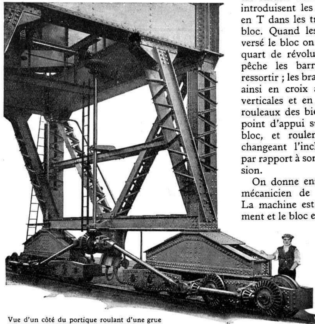
Vue d'un côté du portique roulant d'une grue géante. On voit le détail du mécanisme de translation à transmission par pignons d'angle et roues coniques.
