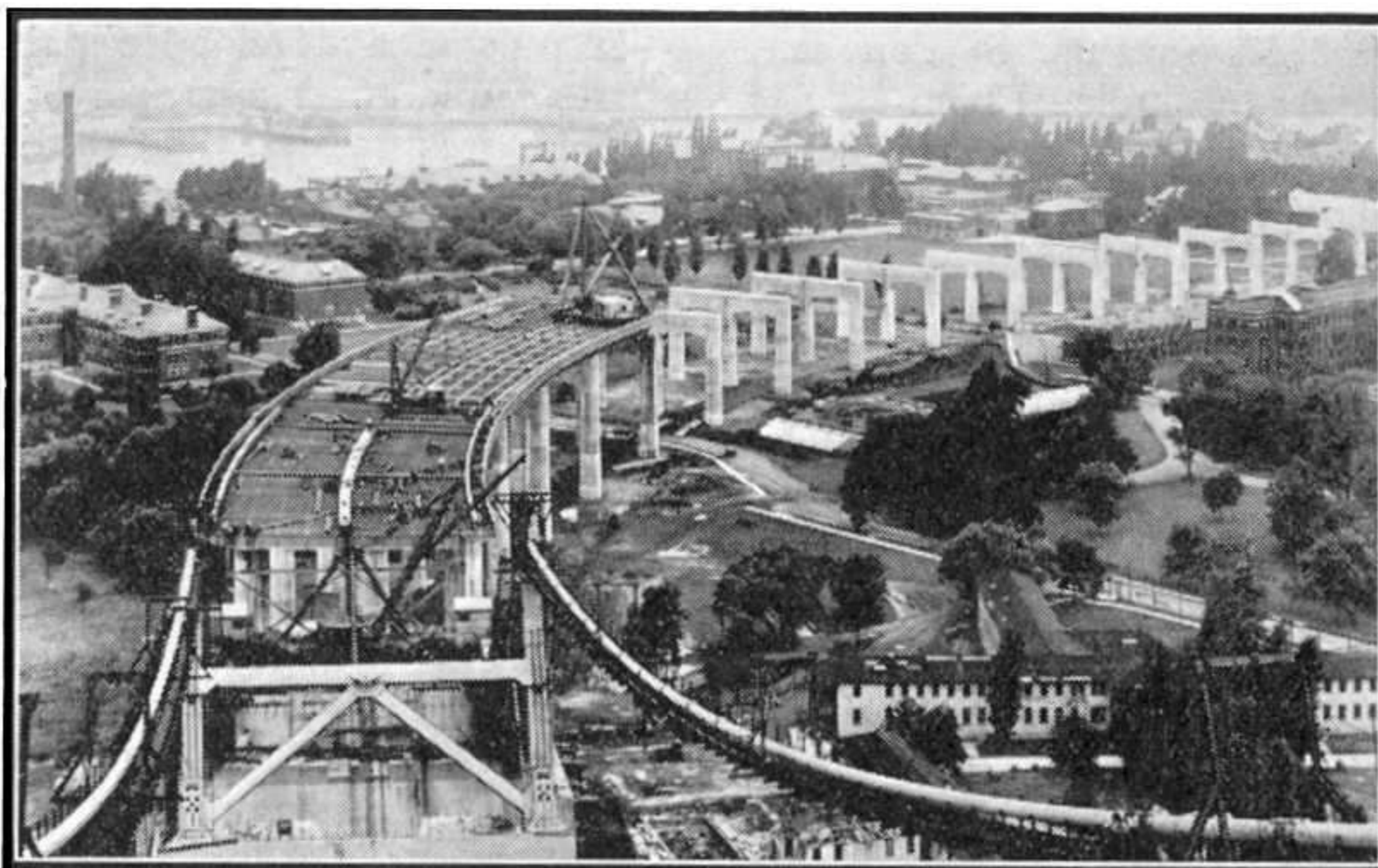
Une vue du viaduc en construction prise du haut d'une des tours du pont suspendu de East River.
