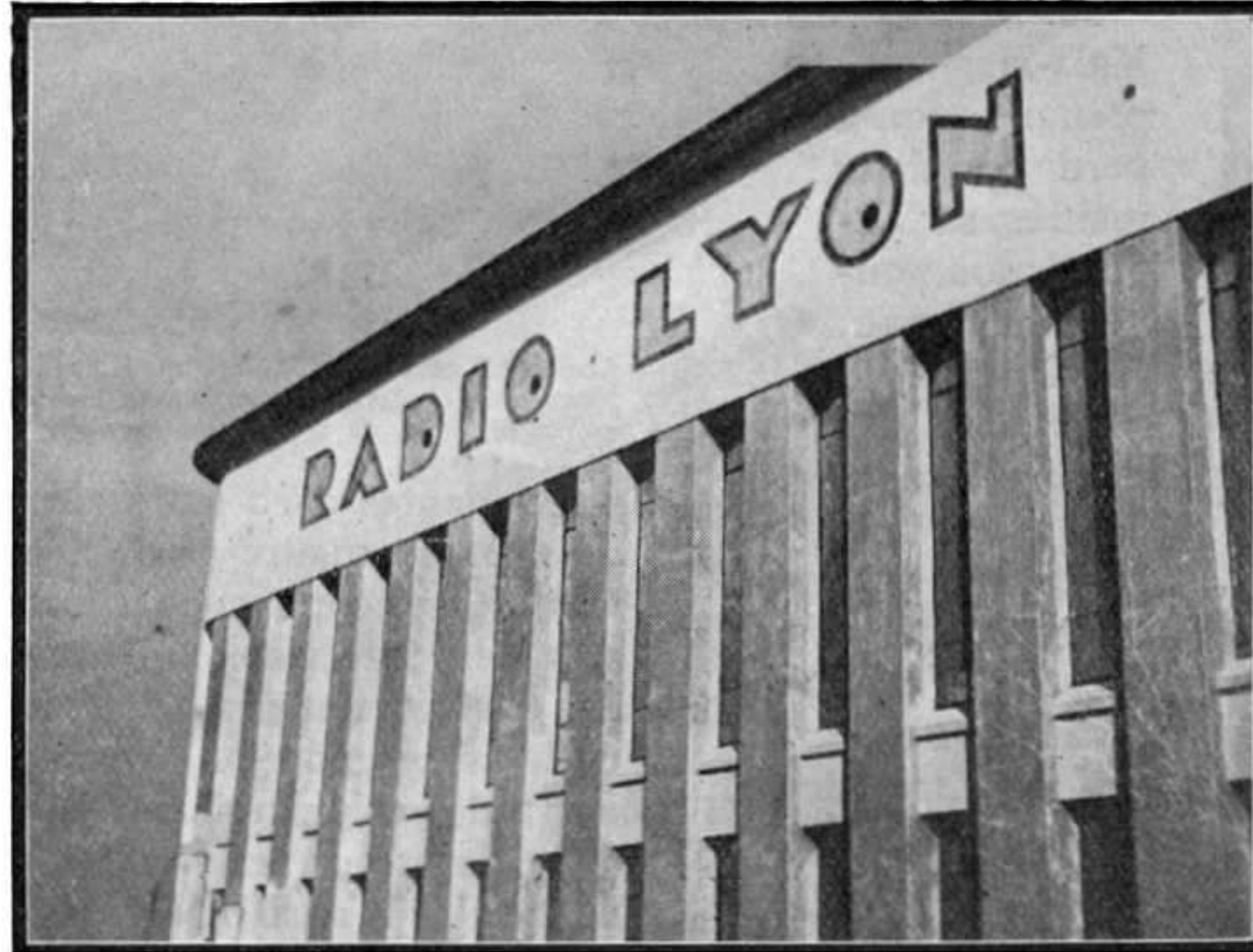
Vue du bâtiment des machines du poste émetteur de Radio-Lyon. Cette photo nous a été remise par l'auteur de l'article, notre lecteur et ami M. Simiand, de Lyon.
