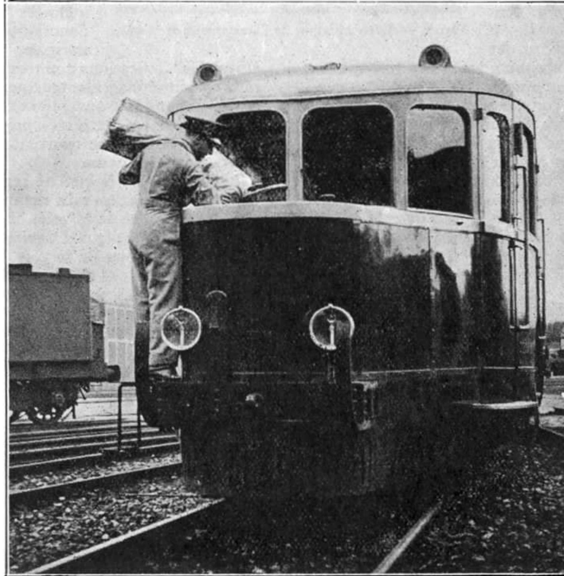
Le chargement du charbon de bois dans l'autorail à gazogène décrit sur cette page. Ce cliché nous a été confié par la revue « Le Génie Civil ».
