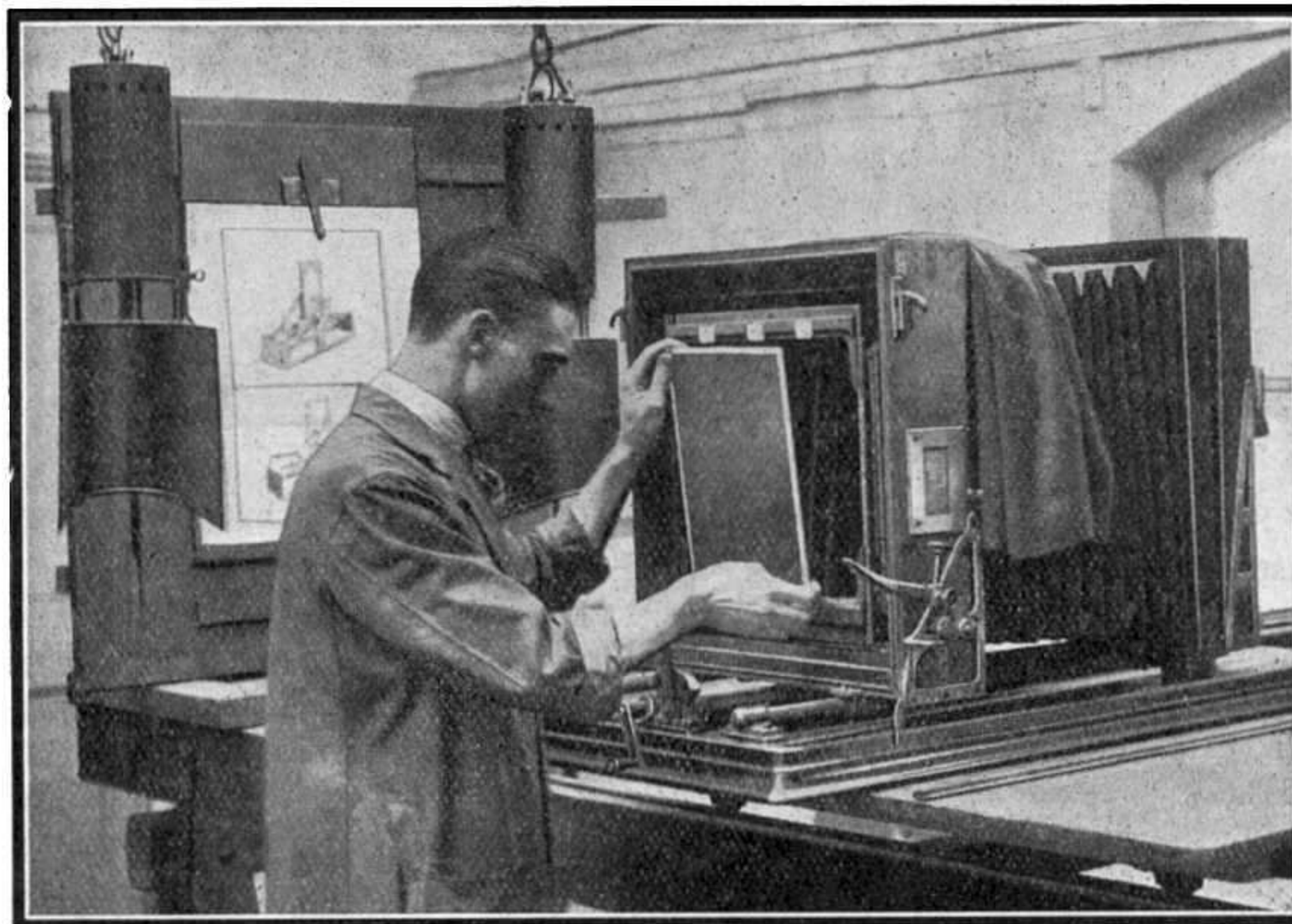
Pose de la trame dans l'appareil de photographie. On remarquera que l'appareil représenté ici n'a que de faibles dimensions. Généralement, ceux des types modernes employés pour ce travail mesurent, comme nous l'avons dit dans notre dernier numéro, jusqu'à 1 m. 50 de longueur et 1 mètre de côté.
