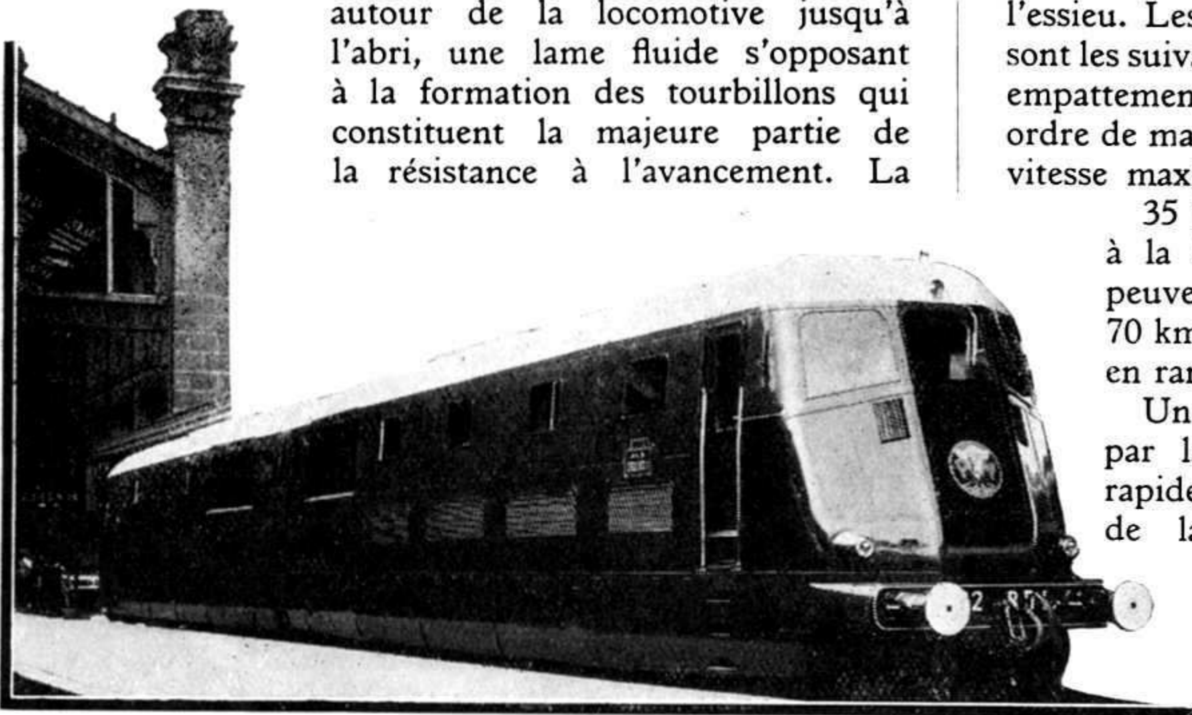
Fig. 4. — Locomotive Diesel électrique à grande vitesse de 4.000 chevaux du P.-L.-M.
