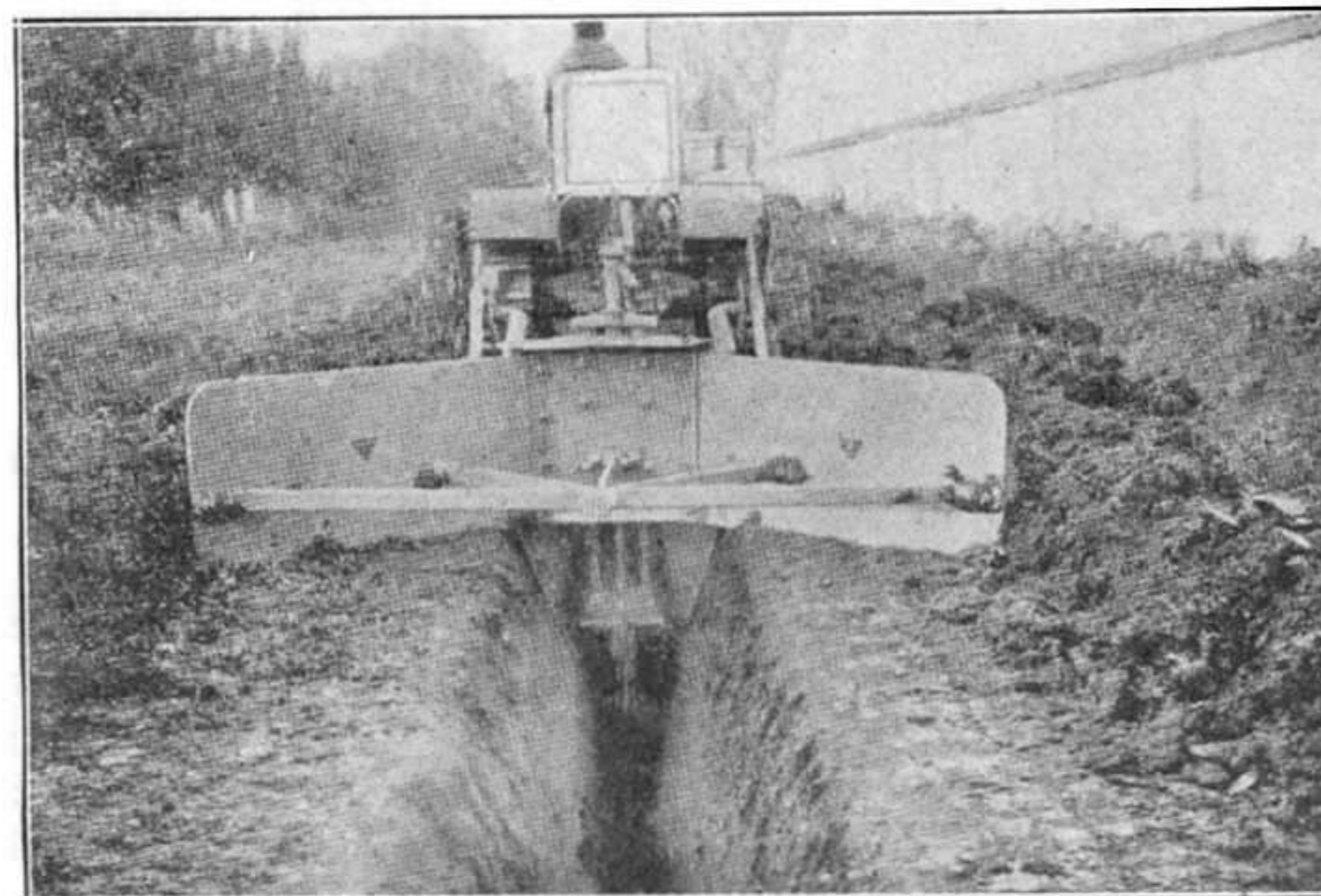
Fossoyeuse pour tranchée étroite en travail.
