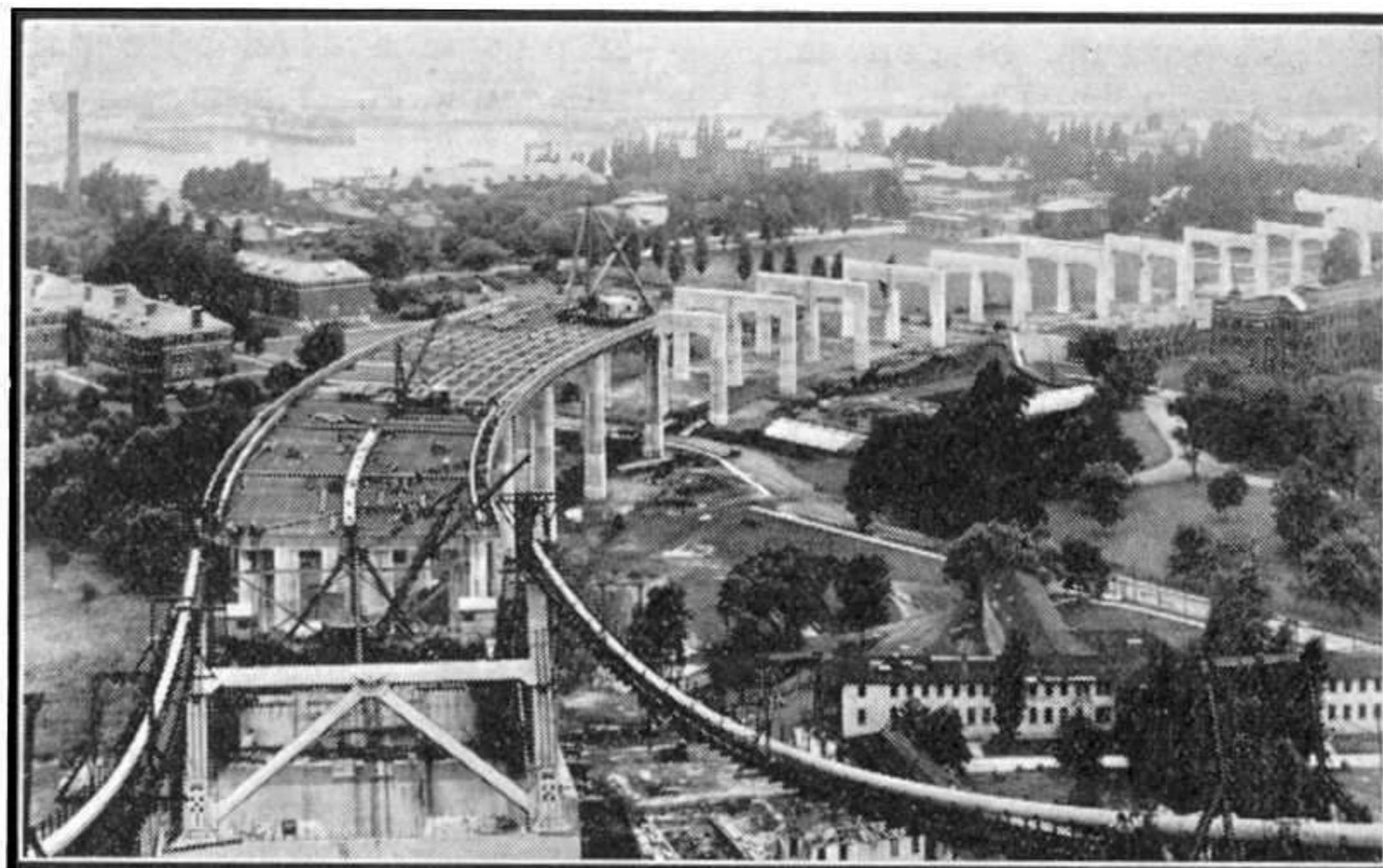
Une vue du viaduc en construction prise du haut d'une des tours du pont suspendu de East River.
