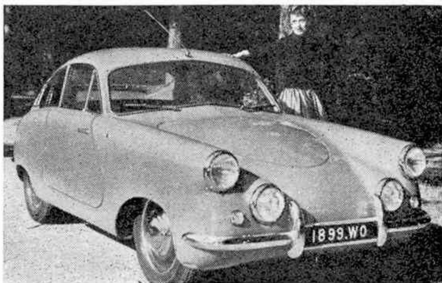
Sensation du Salon 1953 : la « Marathon » dont la carrosserie en matière plastique armée de laine de verre ne pèse que 45 kg.
