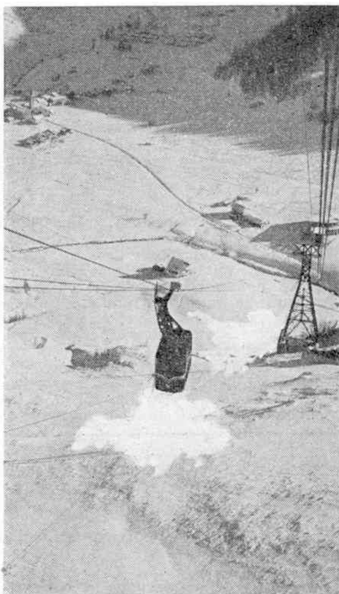
Le téléphérique de Bellevarde, à Val d'Isère (Savoie), a été construit en moins de neuf mois. La cabine (ci-dessus) atteint en cinq minutes trente secondes les magnifiques champs de neige du Rocher de Bellevarde, à 2.774 mètres d'altitude, record de France pour les téléphériques ouverts au public. Dans la gare inférieure, un mécanicien au pupitre du treuil (ci-dessous) surveille attentivement son ascension.
