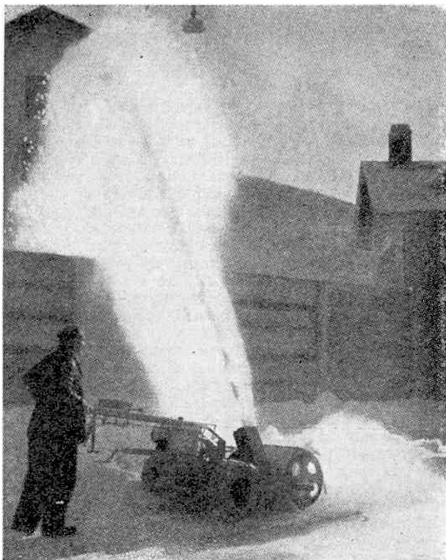
Le « snow-boy » a deux organes essentiels : une fraise à aubes qui détache la neige, la réduit en petits morceaux, la canalise, et un organe chargé de l'accélération et de l'éjection, à une distance qui peut atteindre 20 mètres.
