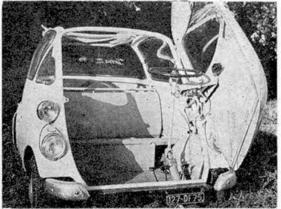
L'Isetta, porte frontale ouverte. Un astucieux système de rotule articule l'arbre de direction.
