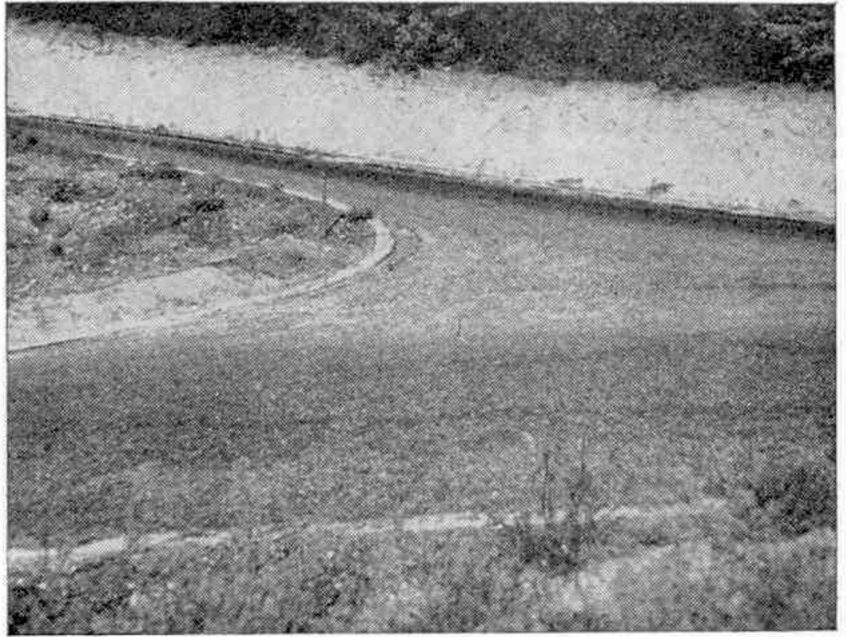
Pistes de la Régie Nationale des Usines Renault à Lardy (Seine-et-Oise). On voit le départ de la pente à 20 % qui coïncide avec la jonction des deux pistes.
