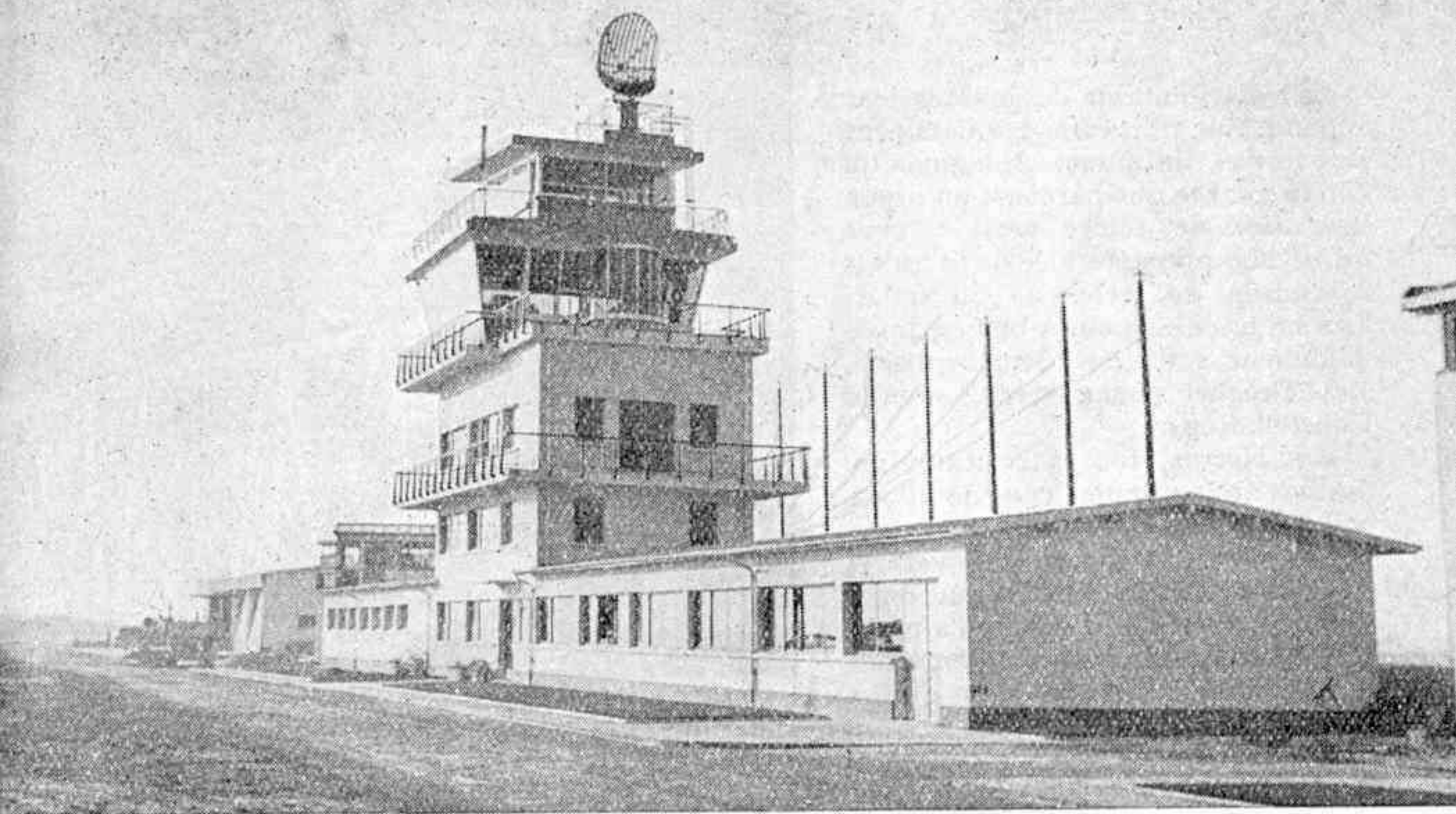
La tour de contrôle, pièce maîtresse de l'échiquier aérien.
