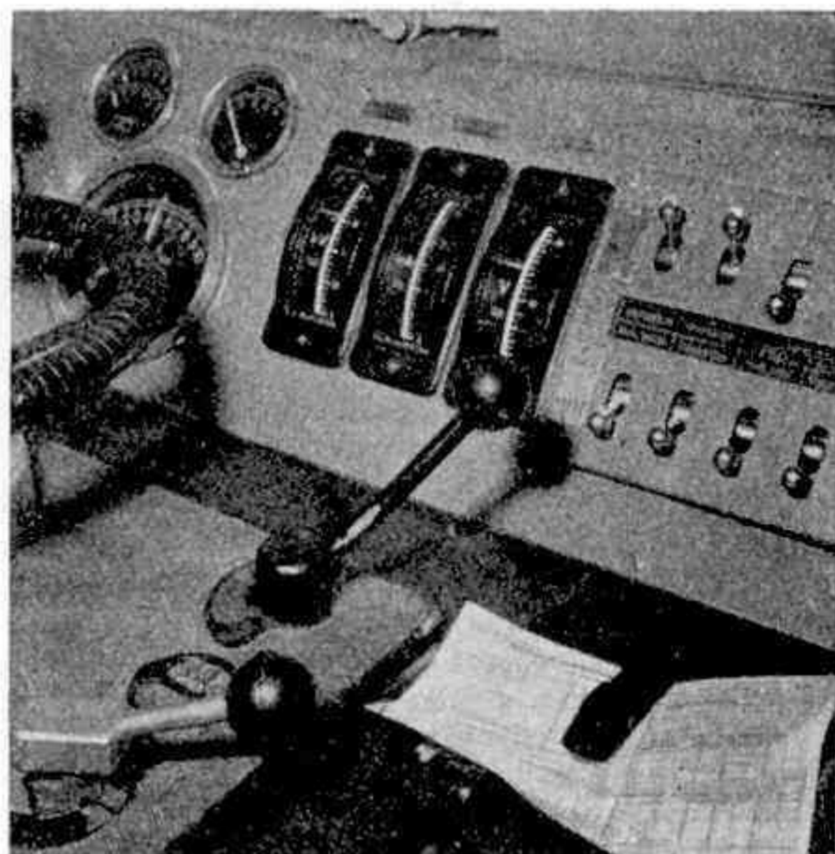
Le tableau de bord de la BB-9004. A gauche le volant manipulateur de vitesse, au centre deux autres manipulateurs, celui du premier plan réglant le couplage des moteurs ; de très nombreux cadrans : à gauche l'ampèremètre, au centre divers voltmètres.
