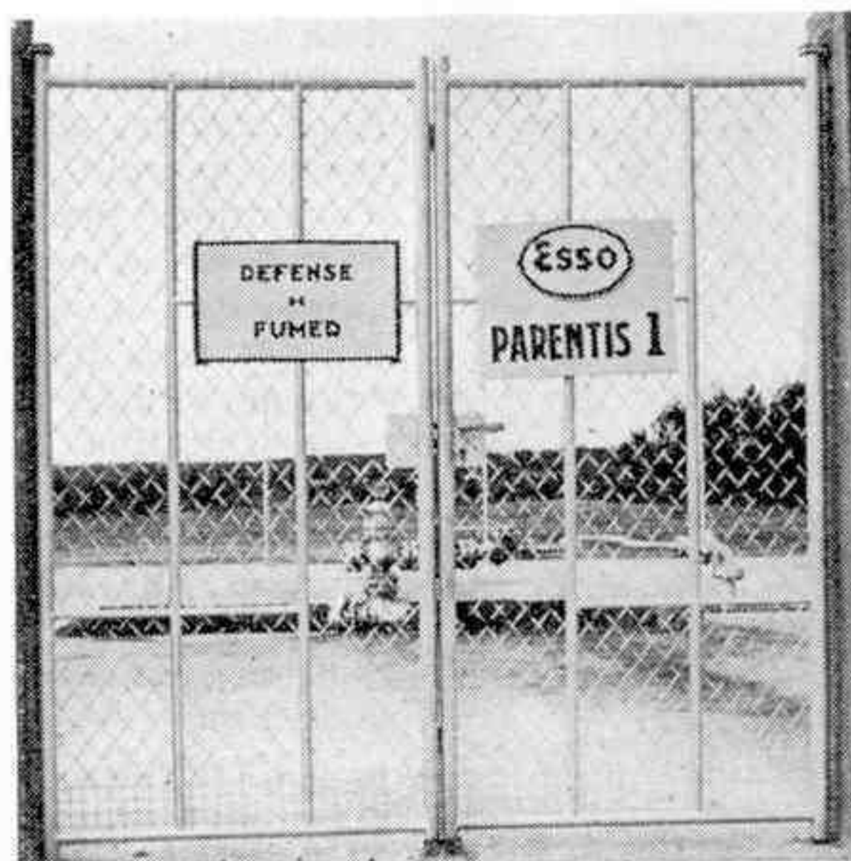
Une porte grillagée, quelques tubes, un « arbre de Noël » c'est Parentis 1, puits en pleine activité.
