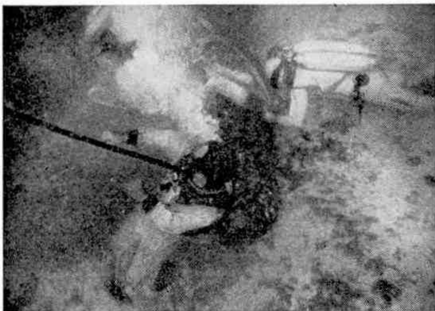
Deux hommes au travail dans le port de Marseille, alors truffé de mines : alors que le scaphandre lourd (à gauche) oblige à des mouvements lents et difficiles, le scaphandre autonome à vêtement spécial (en haut, à droite) laisse au plongeur aisance et rapidité.
