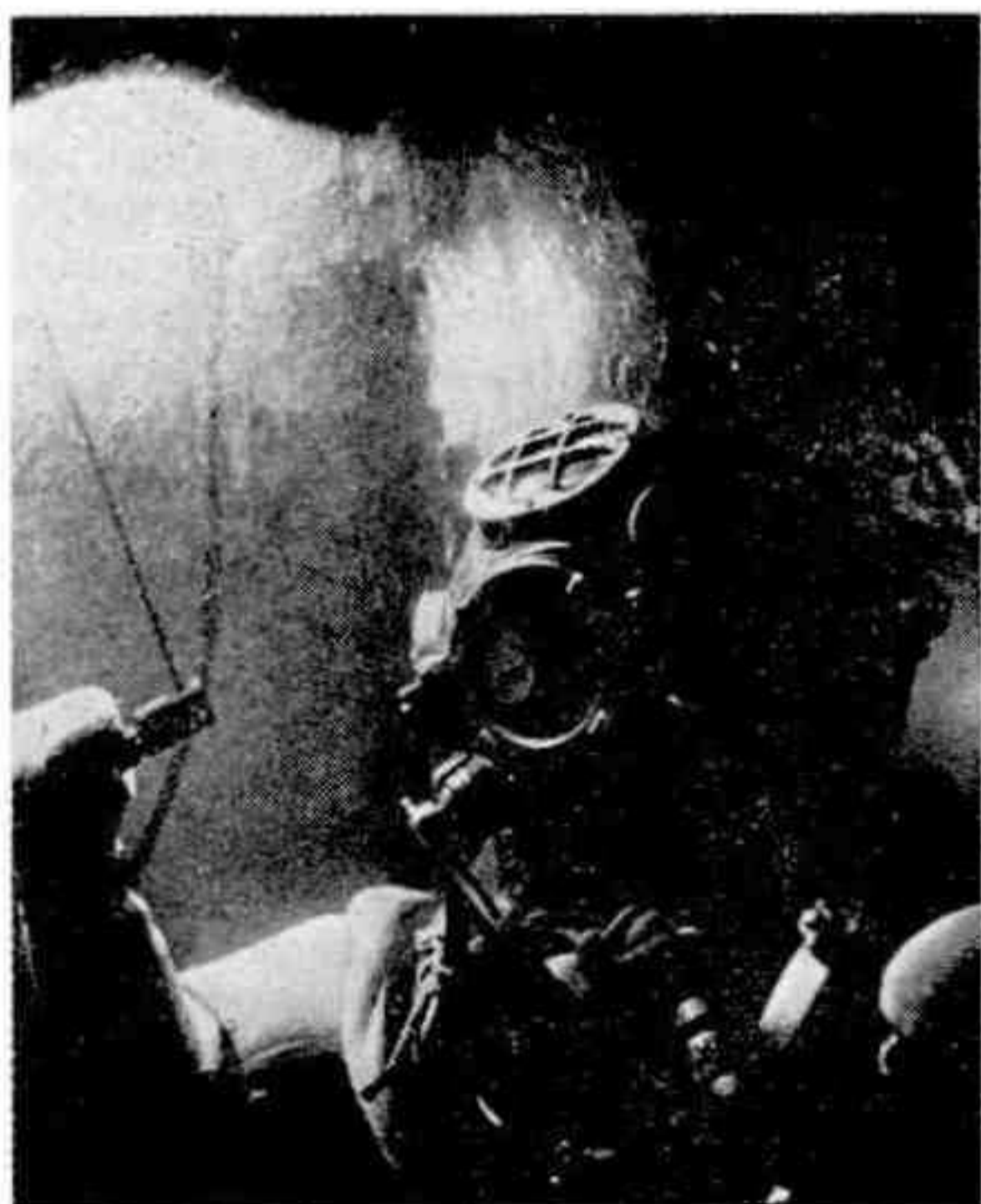
Un scaphandrier au travail : un élève du centre américain de Bayonne, découpe un L. S. T. immergé par plus de 10 mètres, de puissants projecteurs lui facilitent la tâche.
