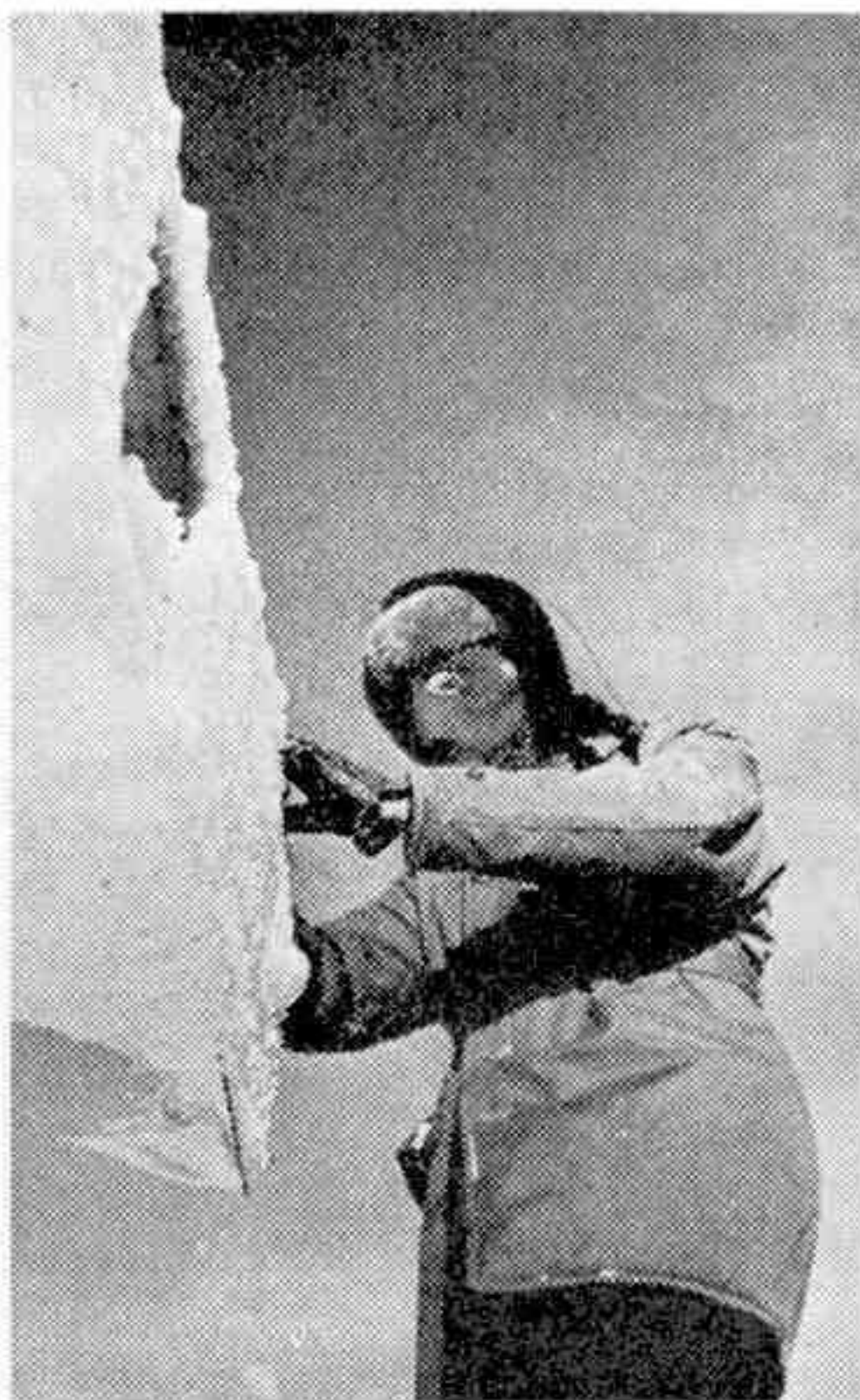
Porteur d'un masque spécial de protection contre le froid, un météorologiste au travail sur le toit d'un bâtiment de l'observatoire du mont Washington (États-Unis). Il retire la couche de glace qui risquerait de faire effondrer le toit.
