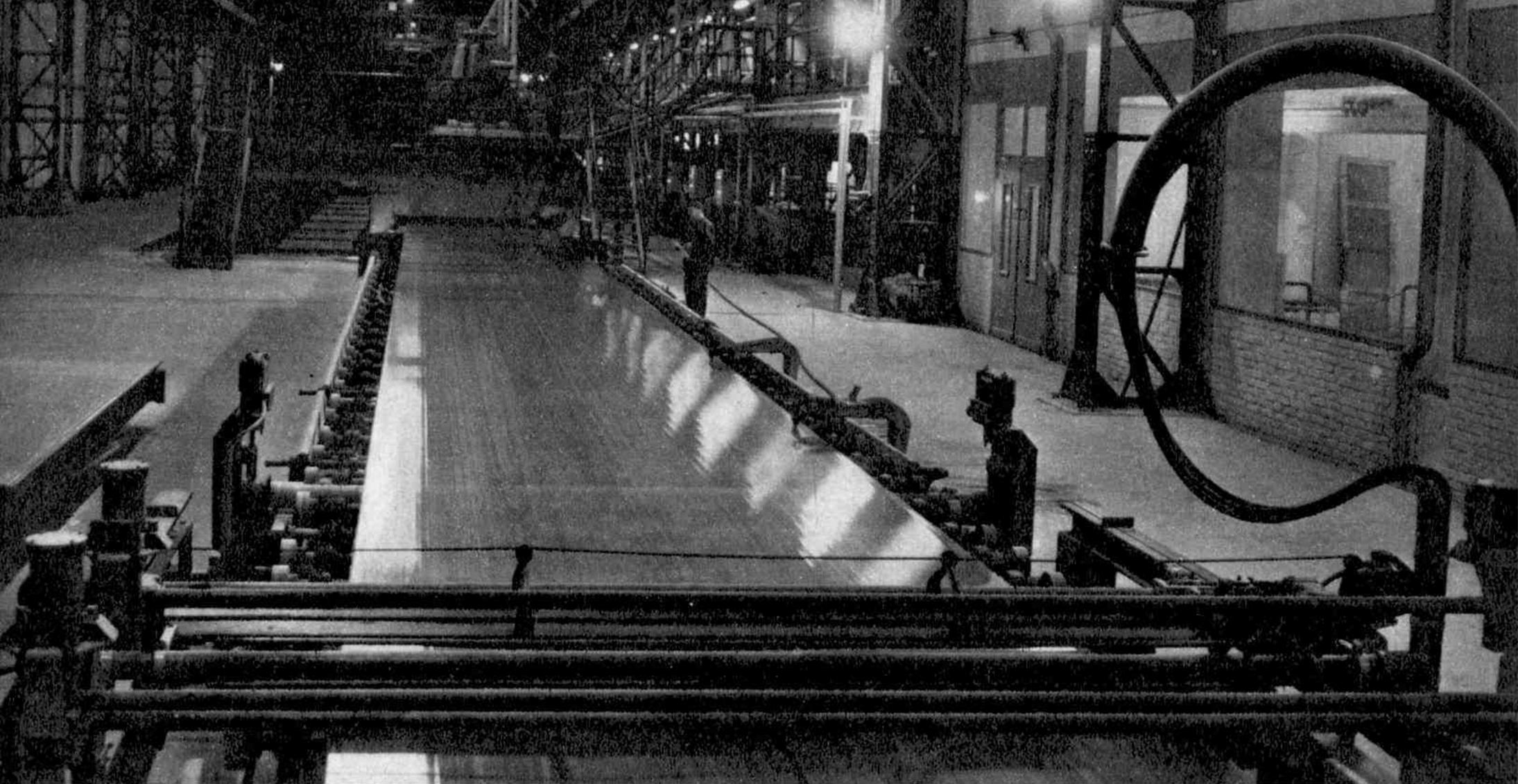
● *Ce long ruban est une glace qui va être doucie mécaniquement et simultanément sur les deux faces (Usines Boussois).*
