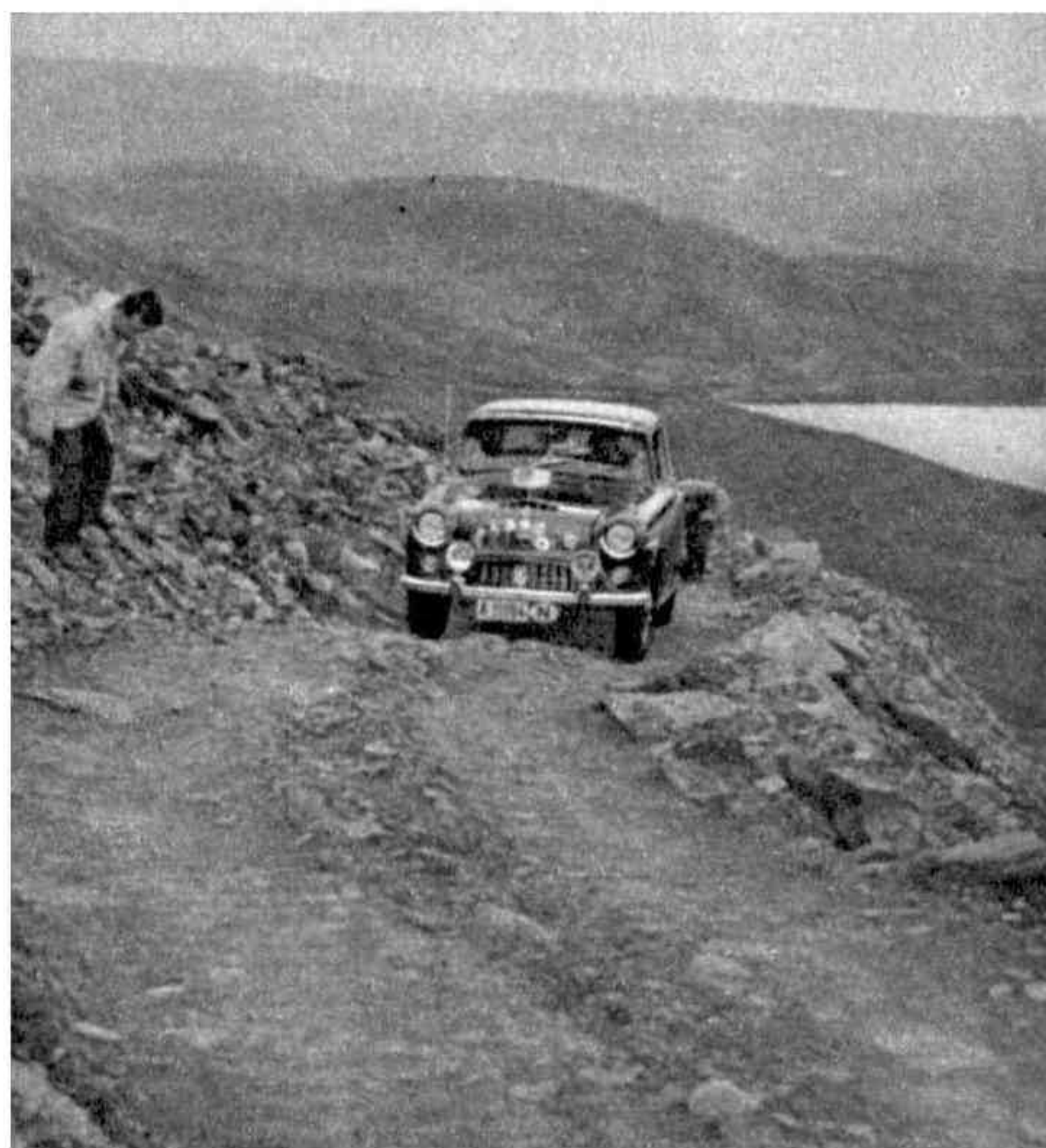
Le gros œuvre de la route a été réalisé avec des engins de terrassement utilisant Esso Diesel Fuel et lubrifiés par Essolube HD.
