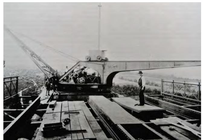
*Original-Drehkran auf der Brücke, unverkleidet*
