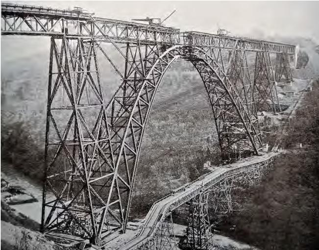
Die Müngstener Brücke ist von Ingenieur Anton von Rieppel und der Maschinenfabrik Augsburg-Nürnberg (MAN) von 1894 bis 1897 entworfen und gebaut worden. Die Brückenteile wurden im Werk Gustavsburg aus Stahl gefertigt, zur Probe montiert, zum Teil wieder zerlegt und mit der Eisenbahn zum Solinger Bauplatz transportiert. Dort wurden die Segmente wieder zusammengesetzt, auf eine Behelfsbrücke unterhalb der Müngstener Brücke gebracht und von zwei Brückenkränen in die Höhe gehoben.
