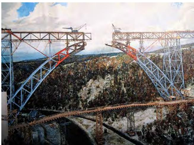
Vorteile eines solchen Brückenprojekts im Modellmaßstab: Die Konstruktion bietet sich wegen ihrer Fachwerkstruktur und ihres Materials geradezu an, mit einem Metallbaukastensystem nachgebaut zu werden. In diesem Fall sind es überwiegend Märklin und etwas Metallus. Ein offensichtlicher Unterschied besteht nur darin, dass das Original genietet (es sollen 950000 Stück sein) und das Modell geschraubt ist.
