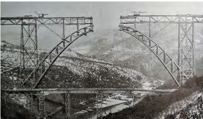
Dort vernieteten Arbeiter die Teile zum Bogen und zum Träger. Die Montage erfolgte von beiden Talseiten aus, so dass die zwei Bogenteile freitragend aufeinander zuwuchsen. Bis schließlich die Lücke geschlossen werden konnte, sorgten Spannseile für den Halt der immer weiter auseinander kragenden Bogen- und Brückenträgerhälften.
