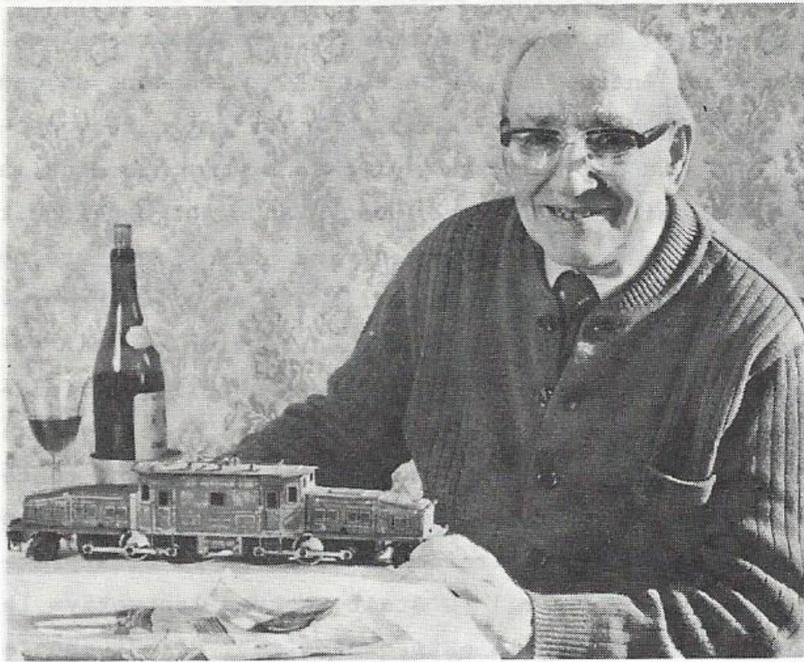
Une photo d'époque, où l'on voit le mécanicien de précision Friedrich Rieker, natif de Souabe. Il faut du calme et du métier pour reproduire une CCS la plus récente "machine Krokodil" suisse à 2 moteurs. Le modèle a une longueur de 45 cm; marche avant et arrière, et est équipée d'une inversion de marche commandée à distance. Rieker est en train de monter les pantographes. Cette photo historique le montre lors du montage de l'un des premiers Krokodils de la série CCS 66.
