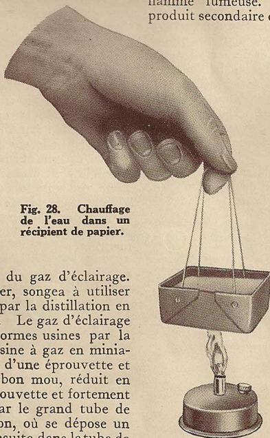
Fig. 28. Chauffage de l'eau dans un récipient de papier.
